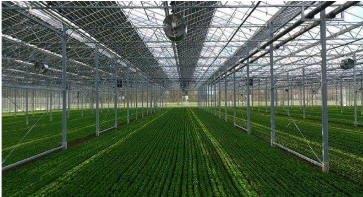
Abbildung 7: Teil-belegtes Dach mit semi-transparenten PV-Module
