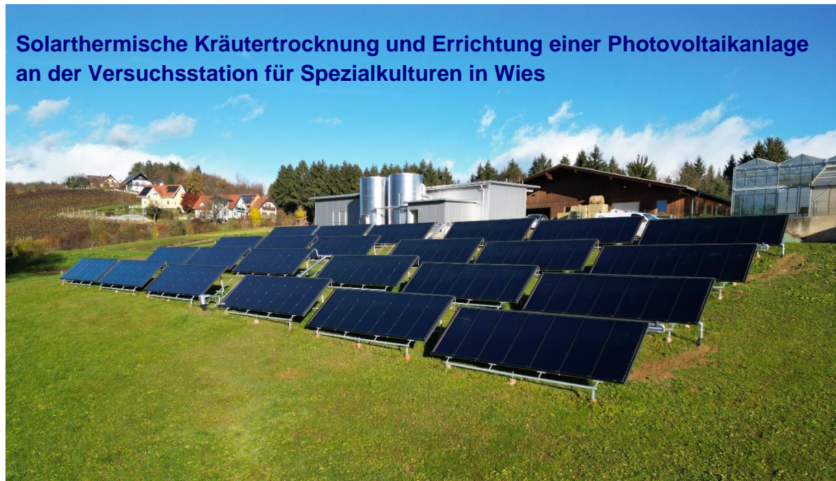
Abb. 1: Solarthermieanlage und Pufferspeicher (Quelle: Firma Wonisch)
