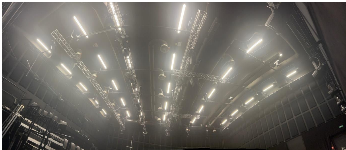
Abbildung 1: LED Deckenbeleuchtung
