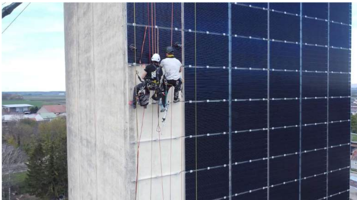
Abbildung 45: Installation der PV-Anlage durch Seilkletterer
