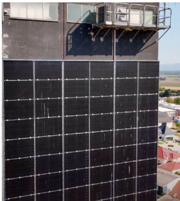
Abbildung 23: Drohnenaufnahme vom 15.08.2024, Darstellung von erhöhter Verschmutzung durch Vogelkot
