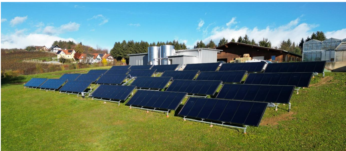
Abbildung 1: installierte Solarthermie-Anlage (Quelle: Versuchsstation für Spezialkulturen Wies)
