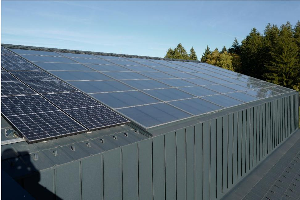
Abbildung 1 südwestliches Luftkollektorfeld mit insgesamt 114,5 m<sup>2</sup> (Quelle: Rudolf Kutschera)
