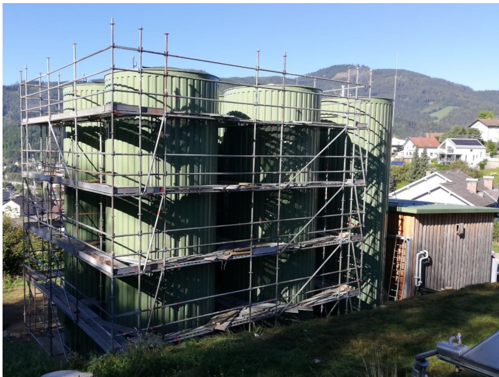
Abbildung 2: Errichtung der zusätzlichen vier Speichertanks zu jeweils 60m 3 . (Quelle: AEE INTEC)
