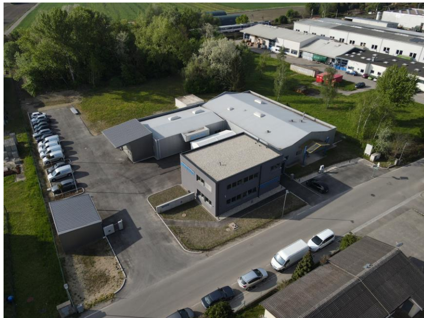
Vor der Errichtung
