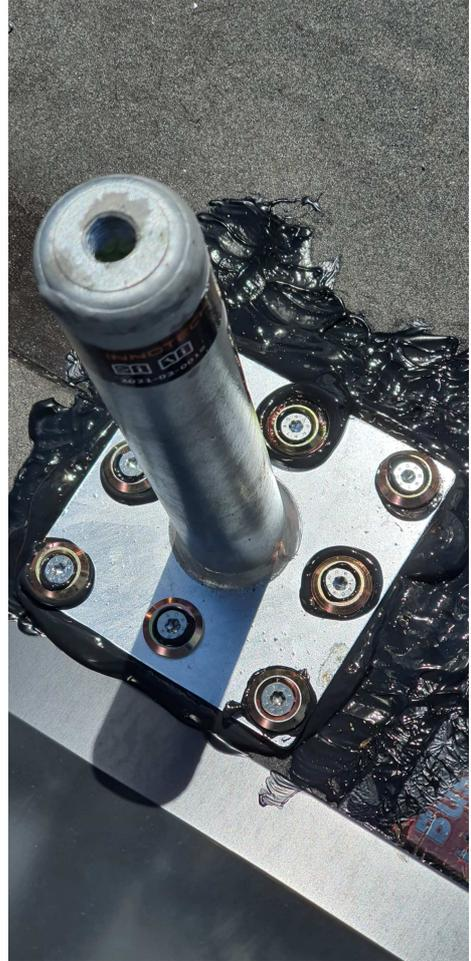
30: Halterungen für Absturzsicherung am Schrägdach mit Triton
