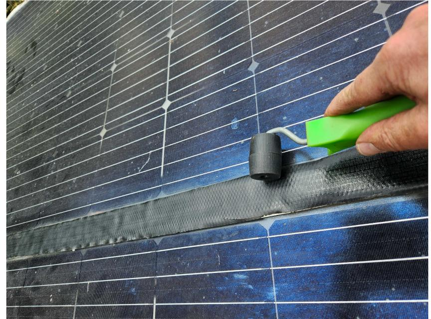
10: Abdichtung der PV Module mit Leadox
