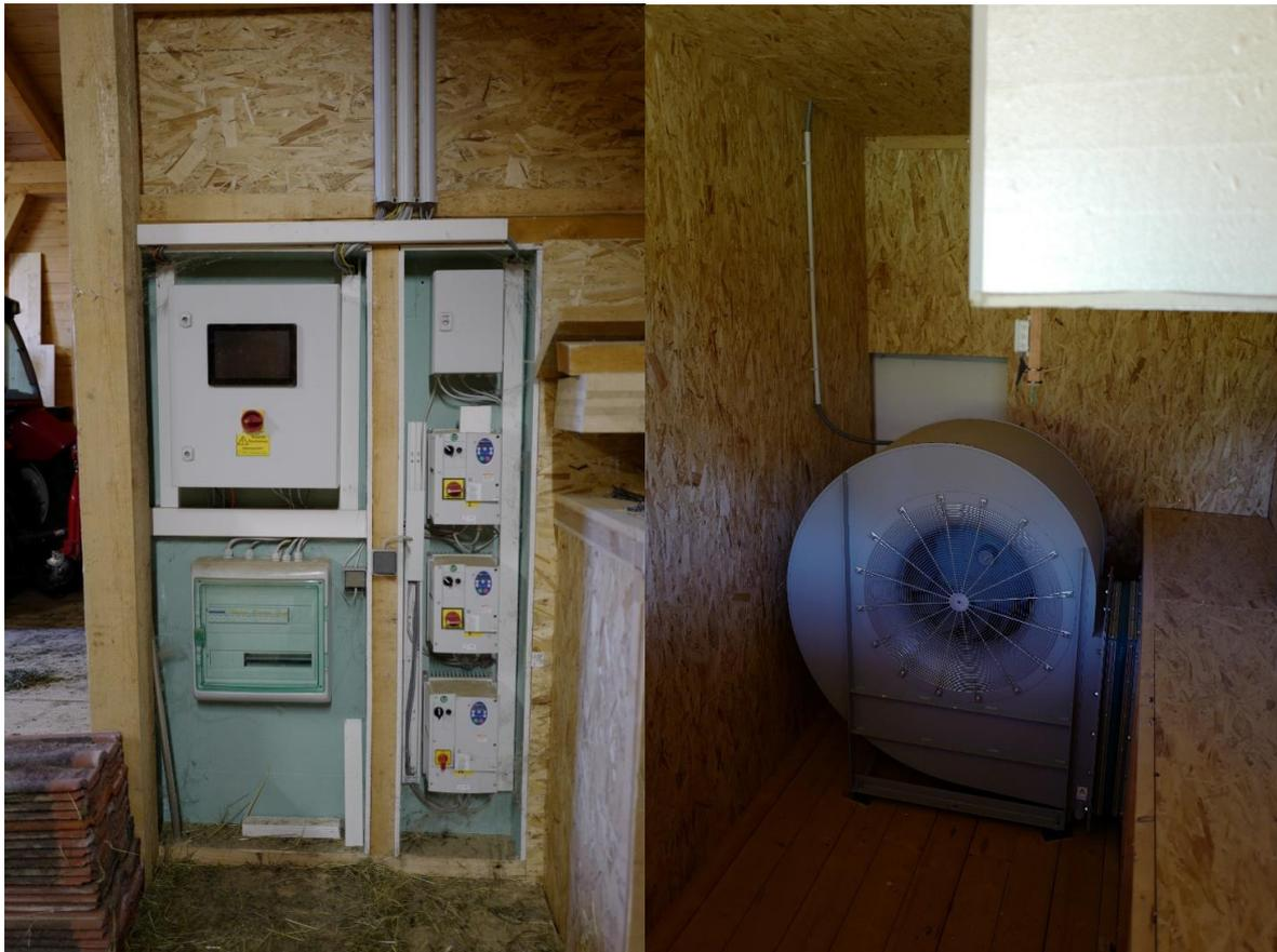
Abbildung 7: Schaltanlage
