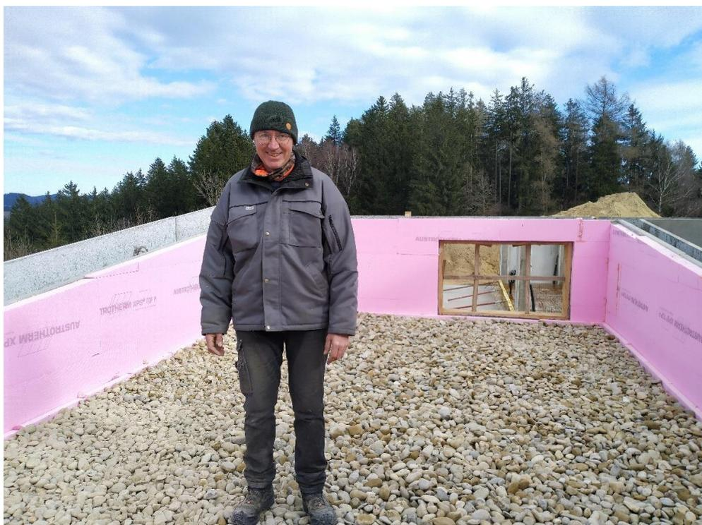
Abbildung 6: Steinspeicher während der Errichtung
