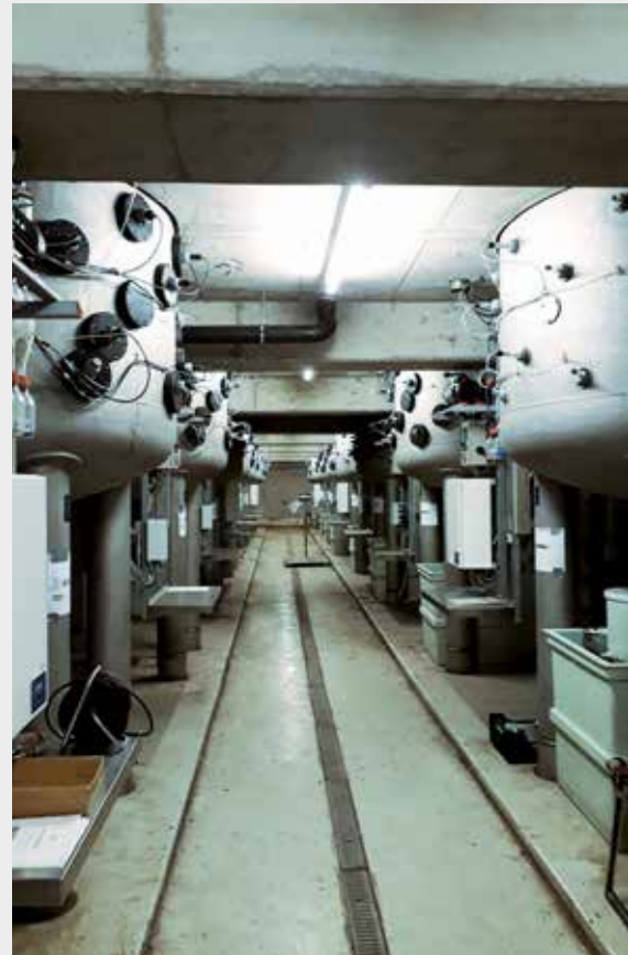
Abb. 2: Keller der Lysimeteranlage der AGES
