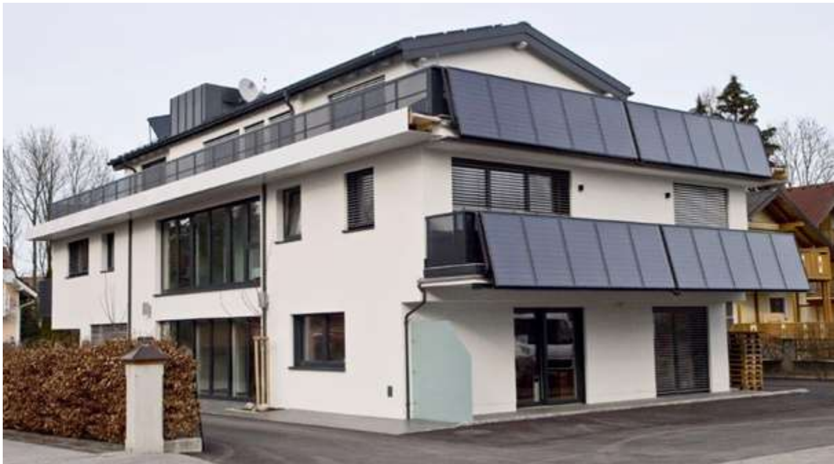
Abbildung 110: Ansicht des Neubaus ALWI Solarbüro (Quelle: FIN - Future is Now GmbH)
