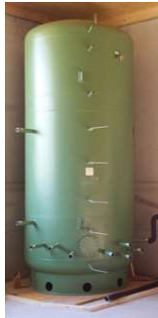
Abbildung 27: Solarschichtspeicher zum Zeitpunkt der Anlagenmontage (Quelle: Franz Kollmann, Conness Solar Errichtungs-GmbH)
