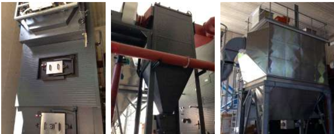
Abbildung 64: Biomassekessel mit 1.990 kW Kesselnennleistung (linke Abbildung) mit nachgeschaltetem Multizyklon (mittlere Abbildung) und Rauchgaskondensation (rechte Abbildung) (Quelle: QM-Baubericht, BC Regionalwärme Ebenthal)
