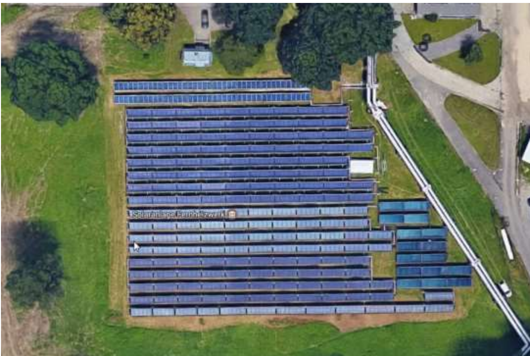
Abbildung 99: Satellitenbild der Solaranlage Fernheizwerk Graz (Bildquelle: Google Maps)
