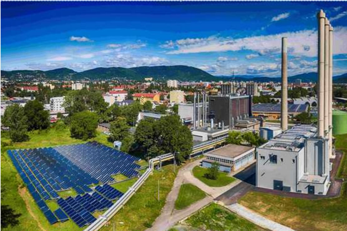
Abbildung 98: Ansicht des Kollektorfeldes auf dem Gelände des Fernheizwerks Graz im Vordergrund. Im Hintergrund ist das Fernheizwerk inkl. Kesselhaus erkennbar. Rechts neben dem Kollektorfeld ist die Fernwärmeleitung zwischen dem Kraftwerk Mellach sowie dem Standort des Fernheizwerks in der Graz-Puchstraße erkennbar (Bildquelle: Picfly.at, Thomas Eberhard)
