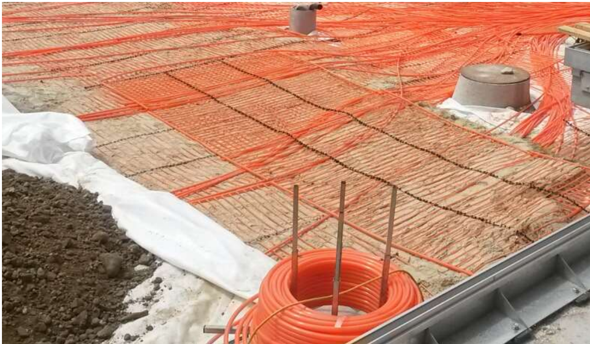
Abbildung 119: Registermatten des Erdspeichers unter dem Parkplatz während der Bauphase. Quelle: Consulting Company Immobilien und Projektmanagement GmbH
