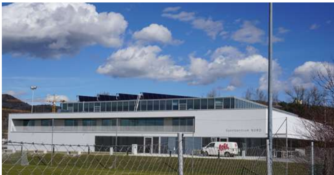
Abbildung 150: Ansicht des Sportzentrum Nord, Lieferung (Bildquelle: AEE INTEC)
