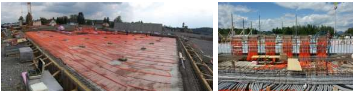
Abbildung 44: Ansicht des Rohrregister (links) Verteiler und Verrohrung der Rohrregister für den Erdspeicher (rechtes Bild) im Zuge der Errichtung (Bildquelle: AEE INTEC)
