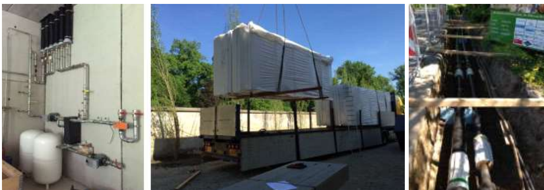
Abbildung 65: Darstellung der Solarkreiswärmetauscher inkl. Ausdehnungsgefäße (linke Darstellung, Quelle: BC Regionalwärme Ebenthal, Ingenieurbüro für erneuerbare Energie), Anlieferung der Solarkollektoren im Zuge der Errichtung (mittlere Darstellung, Quelle: BC Regionalwärme Ebenthal, Ingenieurbüro für erneuerbare Energie), Fernwärmeleitungsbau mit vorisolierten Kunststoffmantelrohren (Quelle: QM-Baubericht, BC Regionalwärme Ebenthal)
