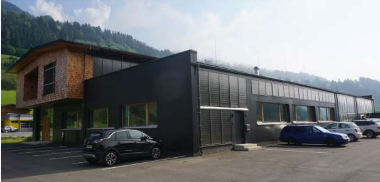
Abbildung 158: Südansicht der Tischlerei Gries – die Solaranlage ist in die Fassade im Erd- und Obergeschoß integriert (Bildquelle: AEE INTEC)
