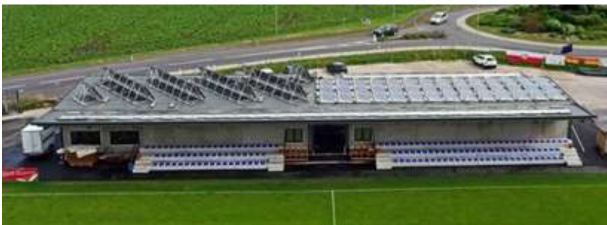
Abbildung 8: Vereinsgebäude mit Solarthermie- und Photovoltaik-Kollektoren auf dem Dach. Quelle: http://www.union-ansfelden.at
