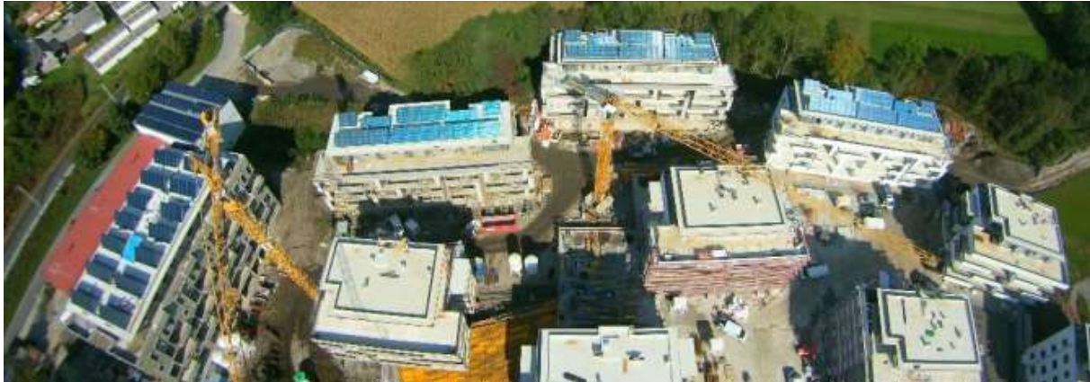
Abbildung 135: Panoramaansicht der neu errichteten bzw. im Bau befindlichen Mehrparteienhäuser des Projekts „Energieinsel Landskron“ (Bildquelle: asteenergy)
