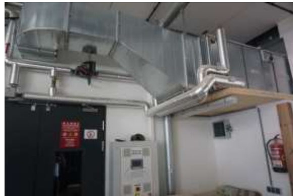
Abbildung 159: Lackierraum (links) und Lüftungsanlage (rechts) über welche der Lackierraum konditioniert wird (Bildquelle: AEE INTEC)
