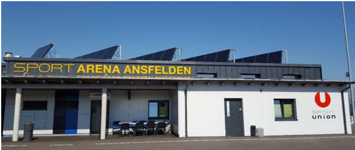
Abbildung 6: Außenansicht Vereinsgebäude mit aufgeständerten Solarthermie-Kollektoren
