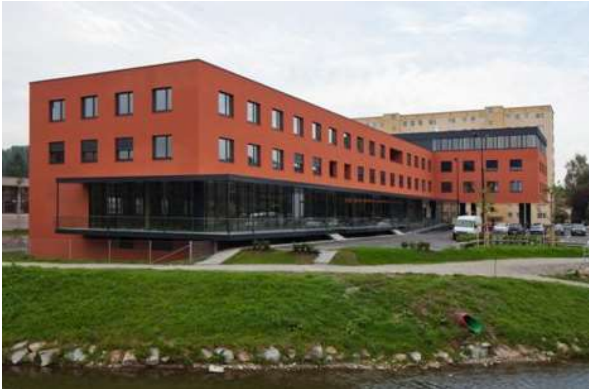
Abbildung 116: Südwestansicht des DLZ Grieskirchen. Quelle: WAIZENAUER BAUUNTERNEHMEN GMBH & CO KG
