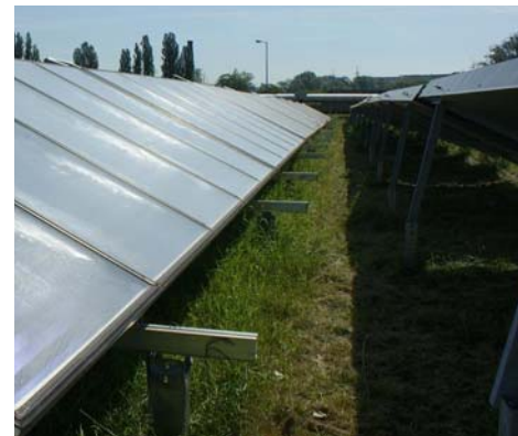
Abbildung 53: Detailansicht zu den im Projekt „Fernheizwerk II, Graz“ (2.490 m 2 ) zum Einsatz gekommenen Rammprofilen (Bildquelle AEE INTEC)
