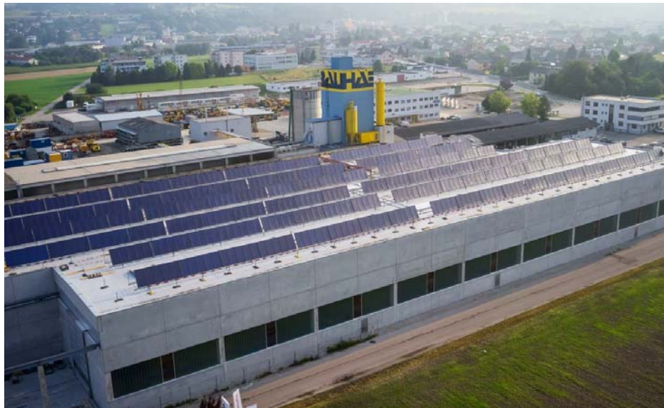
Abbildung 41: Ansicht des Projekts „HABAU Hoch- und Tiefbau GmbH“ mit 1.411 m 2 Bruttokollektorfläche (Bildquelle: www.kuster.co.at )
