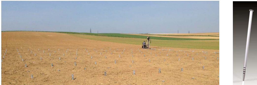
Abbildung 51: Montage der Stahlanker für die Aufnahme der Kollektoren am Betriebsareal (linke Abbildung, Bildquelle: ÖKOTECH) sowie beispielhafte Abbildung eines für die Montage des Kollektorfeldes verwendeten Stahlankers (rechte Darstellung, Bildquelle: terrafix)
