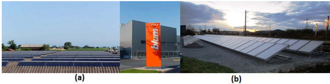
Abbildung 14: (a) Beschlägefabrik Blum, Vlbg. (460m 2 , 16 m 3 Wasserspeicher, SD: 6%, SE: 442 kWh/m 2 a). (b) Fixkraft Kraftfutter, OÖ (324 m 2 , 6m 3 Wasserspeicher, SE: 343 kWh/m 2 a); Bildquellen: Ritter XL Solar (Blum), AEE INTEC (Fixkraft)
