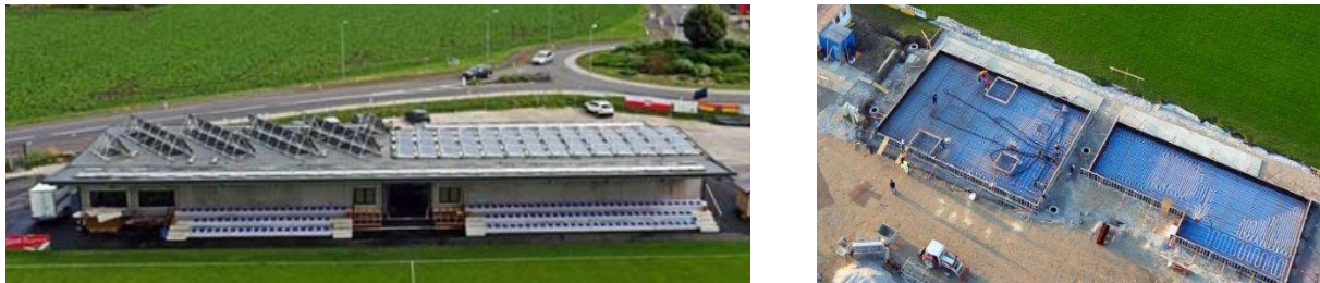
Abbildung 18: Links: Ansicht des Sportvereinsgebäude Ansfelden mit bereits montiertem thermischem Kollektor als auch der montierten PV-Anlage. Rechts: Dieses Bild zeigt die bereits verlegten Rohrleitungen zur Aktivierung der Fundamentplatte noch vor dem Einbringen des Betons. Der Start der einjährigen Monitoringphase steht zum Zeitpunkt der Berichtslegung unmittelbar bevor. Bildquellen: Harald Kuster
