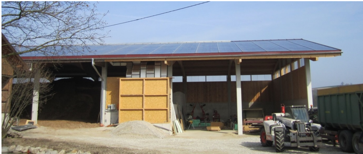
Abbildung 19: Süd-Ansicht der Halle mit der Luftkollektoranlage. Quelle: AIT
