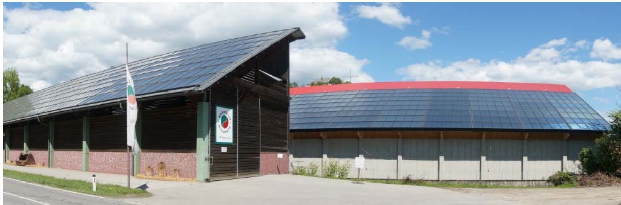
Abbildung 47: Ansicht der beiden Kollektorfelder als Panoramafoto (links: 1.250 m 2 Altbestand; rechts: 1.200 m 2 Neubau) der Anlage „Nahwärme Eibiswald“, Bildquelle: AEE INTEC
