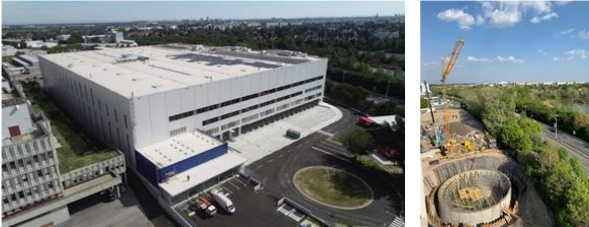
Abbildung 19: Links: Ansicht des IKEA Logistikzentrums im 21. Wiener Gemeindebezirk. Im hinteren Dachbereich sind die Absorbermatten, davor eine PV-Anlage mit 1MWp. Rechts: Eindrücke aus der Errichtungsphase des Eisspeichers. Bildquellen: IKEA
