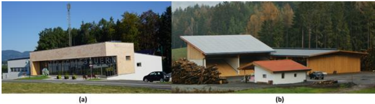
Abbildung 12: (a) Weizer Schafbauern, Stmk. (114 m 2 , 10 m 3 Wasserspeicher, SD: 12%, SE: 396 kWh/m 2 a). (b) Regionalenergie Natters, T. (219 m 2 , SD: 100%, SE: 727 kWh/m 2 a); Bildquellen: AEE INTEC
