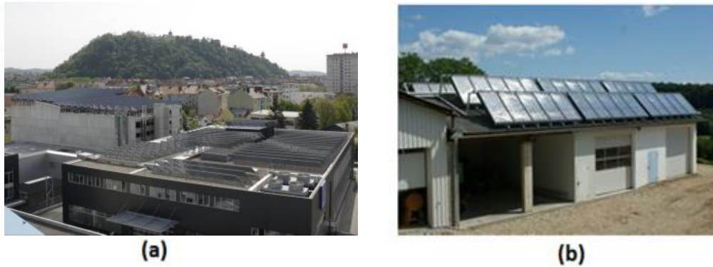
Abbildung 17: (a) AVL, Stmk. (1.879 m 2 , 70m 3 , SD kälte : 6%, SE: 321 bzw. 395 kWh/m 2 a; SPF th. : 0,75). (b) Obstsaftproduktion Krispel (100 m 2 , 20m 3 Wasserspeicher, SD: 30%, SE: 374 kWh/m 2 a SPF el. : 3,5; SPF th. : 0,4); alle Bildquellen: AEE INTEC
