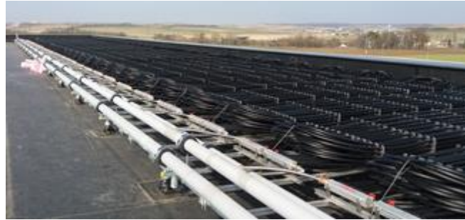
Abbildung 23: Absorbermatten-Bündel (Quelle: Ökoplan Energiedienstleistungen GmbH)
