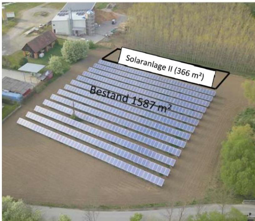
Abbildung 1: Solaranlage I mit Standort der neu errichteten Solaranlage II
