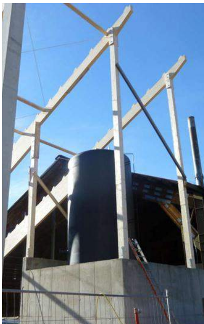
Abbildung 64: Ansicht der beiden Pufferspeicher (links: 68,5 m 3 Neuerrichtung; rechts: 105 m 3 Bestand) der Anlage "Nahwärme Eibiswald", Bildquelle: Ökotech (links), AEE INTEC (rechts)
