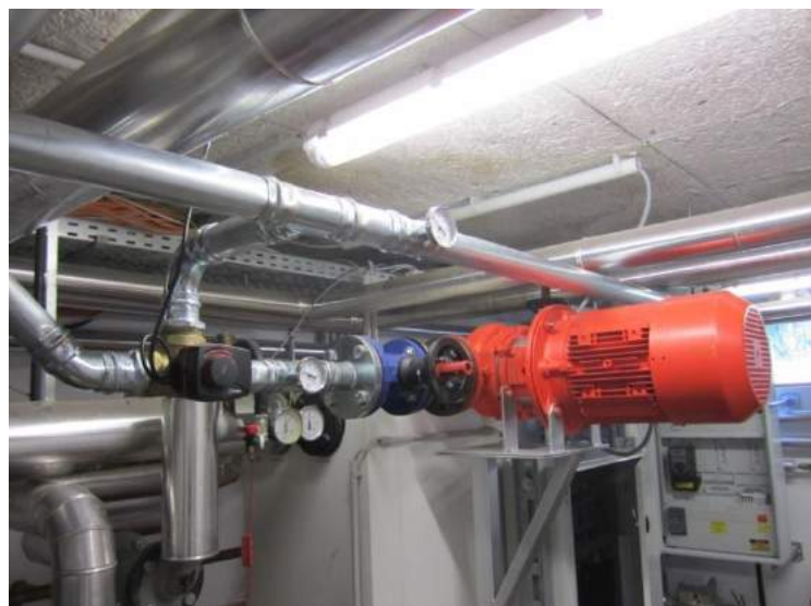
Abbildung 133: Linkes Bild: Solarprimärpumpen (rechts oben), Solarwärmetauscher (unten) sowie Solarsekundärpumpe (links) und Wärmehähler im Solarsekundärkreis (oben) im Amtshaus Scharnstein; Rechtes Bild: Drei-Weg-Ventil mit Stellmotor (links) und Netzpumpe (rechts) im Amtshaus Scharnstein
