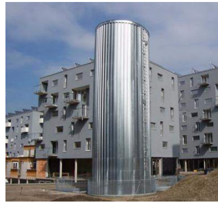
Abbildung 100: Ansicht einiger Geschößwohnbauten mit Kollektorfeld am Flachdach (links) sowie des Pufferspeichers (rechts) der Anlage "Salzburg Lehen", Bildquelle: Salzburg AG
