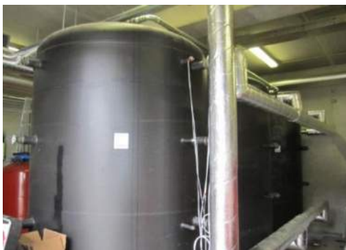
Abbildung 204: Die drei, zum Zeitpunkt des Fotos noch nicht wärmegeämmten Pufferspeicher der Solaranlage im Heizhaus (linkes Bild), Warmwasserspeicher und Heizungsverteiler im Technikraum des Restaurantgebäudes (rechtes Bild). Quelle: AIT
