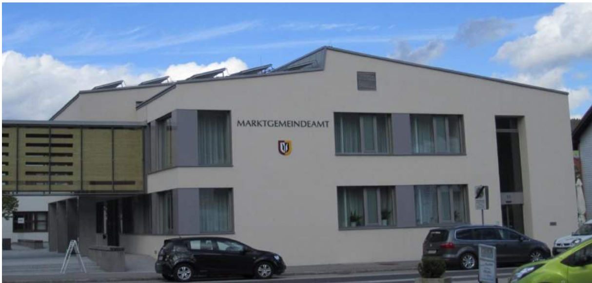
Abbildung 126: Frontansicht des Gebäudes „Amtshaus Scharnstein“ auf dessen Dachflächen die unterschiedlich orientierten Flachkollektorfelder montiert sind
