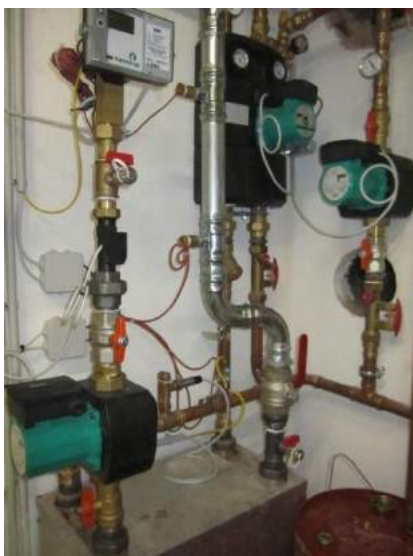
Abbildung 133: Linkes Bild: Solarprimärpumpen (rechts oben), Solarwärmetauscher (unten) sowie Solarsekundärpumpe (links) und Wärmehähler im Solarsekundärkreis (oben) im Amtshaus Scharnstein; Rechtes Bild: Drei-Weg-Ventil mit Stellmotor (links) und Netzpumpe (rechts) im Amtshaus Scharnstein
