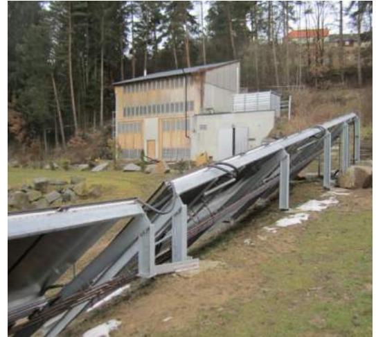
Abbildung 202: Restaurantgebäude (linkes Bild), aufgeständerte Kollektoren und Heizhaus (rechtes Bild). Quelle: AIT
