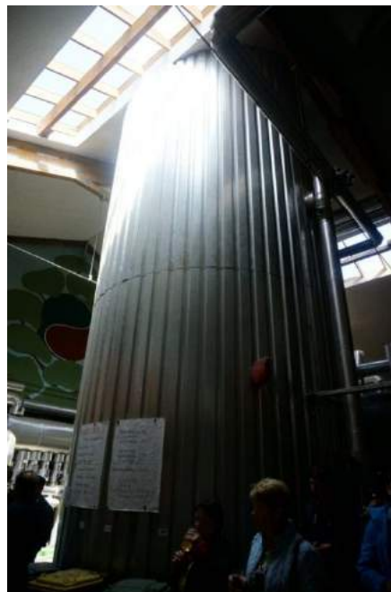
Abbildung 64: Ansicht der beiden Pufferspeicher (links: 68,5 m 3 Neuerrichtung; rechts: 105 m 3 Bestand) der Anlage "Nahwärme Eibiswald", Bildquelle: Ökotech (links), AEE INTEC (rechts)
