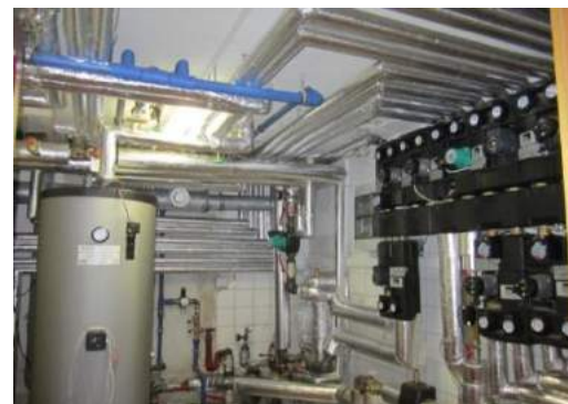
Abbildung 204: Die drei, zum Zeitpunkt des Fotos noch nicht wärmegeämmten Pufferspeicher der Solaranlage im Heizhaus (linkes Bild), Warmwasserspeicher und Heizungsverteiler im Technikraum des Restaurantgebäudes (rechtes Bild). Quelle: AIT
