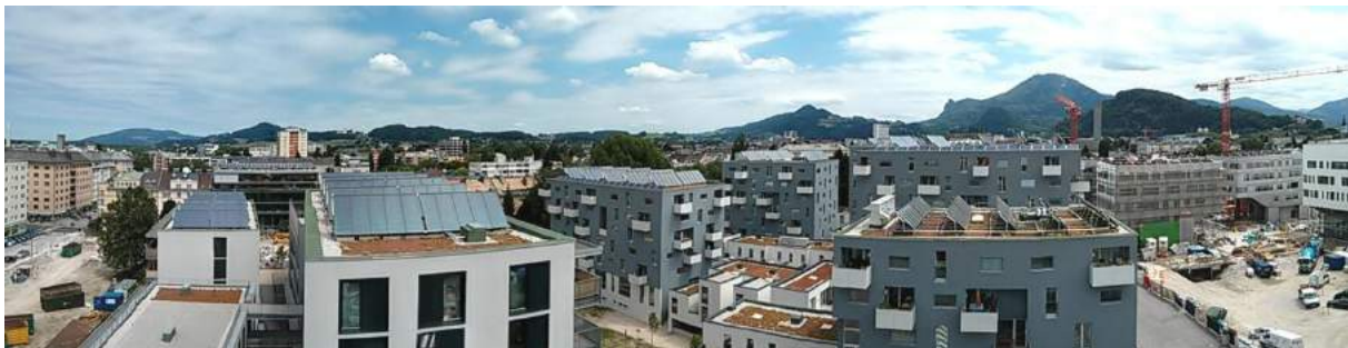
Abbildung 99: Panoramaansicht der neu errichteten Geschosswohnbauten im Stadtteil „Salzburg Lehen“ mit den Kollektorfeldern auf den Dächern, Bildquelle: AEE INTEC
