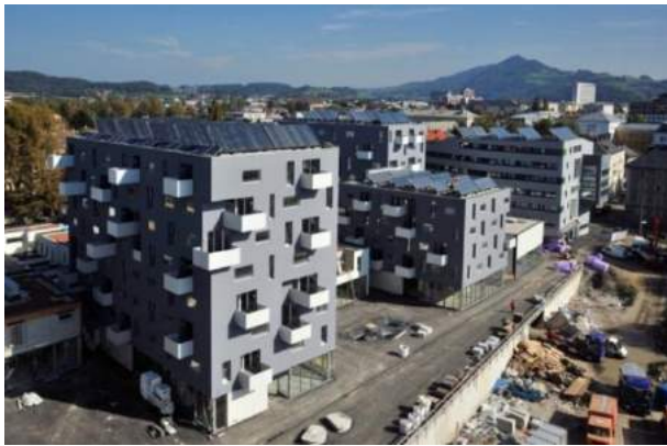
Abbildung 100: Ansicht einiger Geschößwohnbauten mit Kollektorfeld am Flachdach (links) sowie des Pufferspeichers (rechts) der Anlage "Salzburg Lehen", Bildquelle: Salzburg AG
