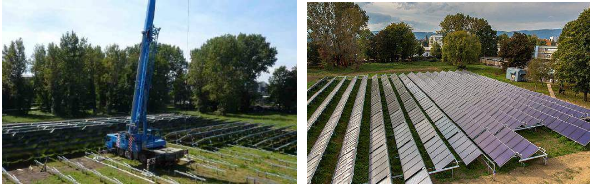
Abbildung 153: Ansicht im Zuge der Errichtung des Kollektorfeldes (linke Abbildung, Bildquelle: SOLID) und Ansicht des fertig errichteten Kollektorfeldes auf dem Gelände des Fernheizwerks Graz (rechte Abbildung, Bildquelle: „Kleine Zeitung“)
