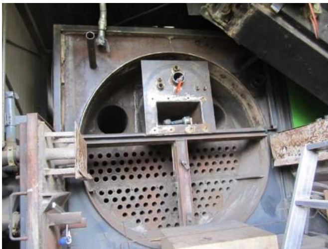
Abbildung 129: Blick in den für Reparaturen geöffneten Biomasseheizkessel im Biomasseheizwerk Almau 2
