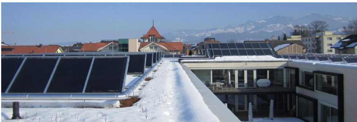
Abbildung 31: Ansicht des Gebäudes „Sozialzentrum Rankweil“ mit Blick auf die Solarthermie-Kollektoren am Flachdach (links) und am Sheddach des Gebäudes (Mitte rechts). Auf dem Flachdach außerdem die kleineren Photovoltaik-Module (Mitte links im Hintergrund und ganz rechts im Hintergrund)
