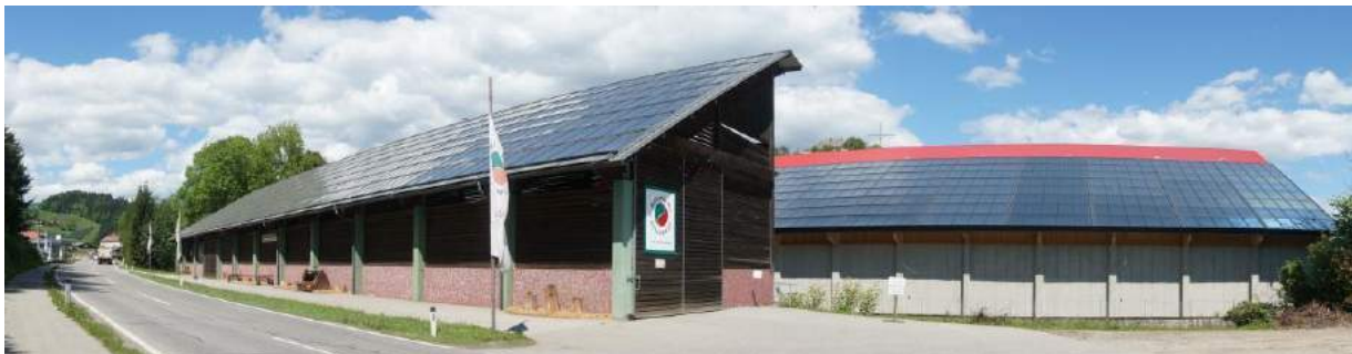
Abbildung 62: Ansicht der beiden Kollektorfelder als Panoramafoto (links: 1.250 m 2 Altbestand; rechts: 1.200 m 2 Neubau) der Anlage "Nahwärme Eibiswald", Bildquelle: AEE INTEC
