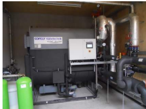
Abbildung 7: Ansicht der neuen Produktionshalle der Anlage „Kral Pumpen Lustenau“ (links) und 150 kW Absorptionskältemaschine (rechts), Bildquelle: AEE INTEC
