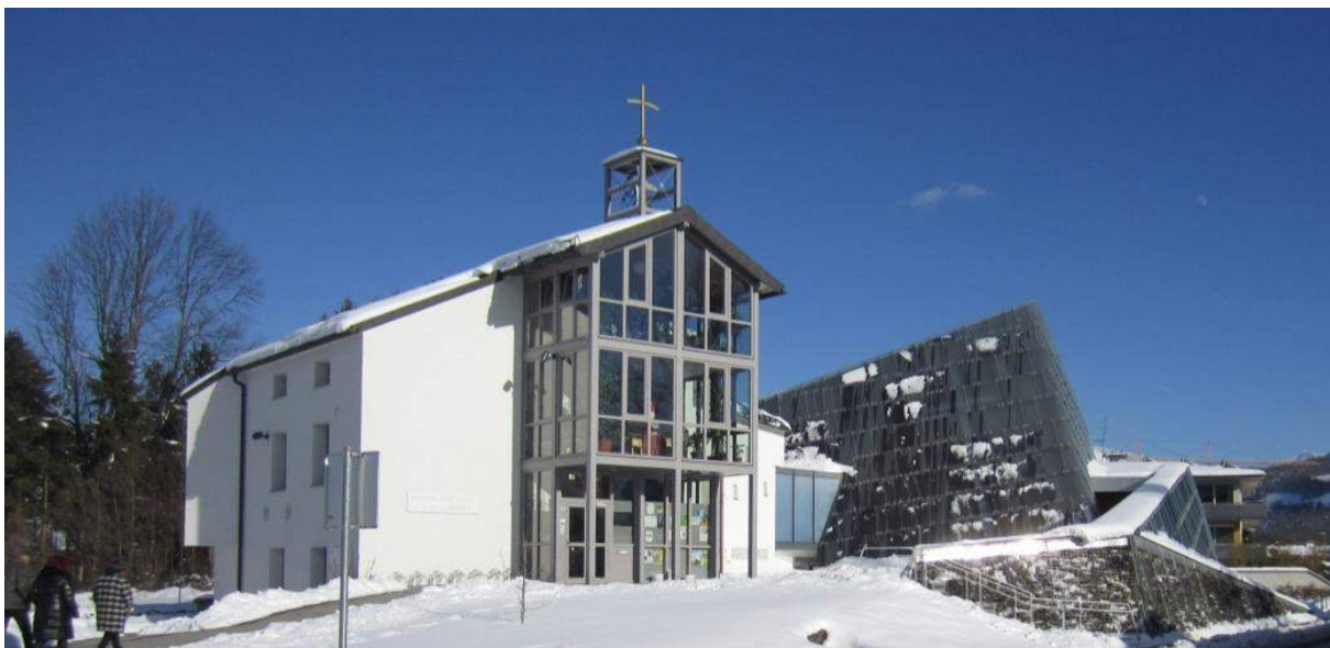
Abbildung 166: Ansicht des Gebäudes „Pfarrzentrum Rif“ mit Blick auf den bestehenden Pfarrhof im Vordergrund links und die neugebaute Kirche im Hintergrund rechts
