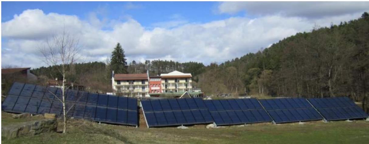
Abbildung 200: Ansicht des Hotelgebäudes im Projekt "Hotelrestaurant Liebnitzmühle", davor die aufgeständerten Kollektorfelder. Quelle: AIT
