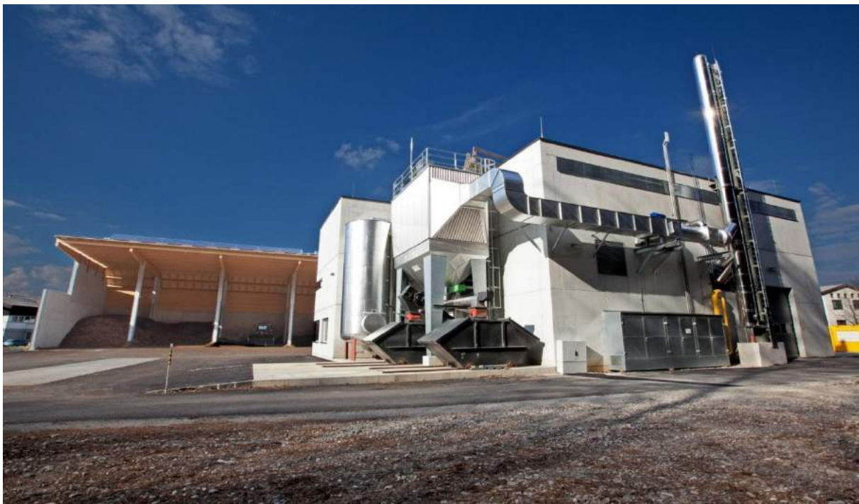
Abbildung 183: Frontansicht des Betriebsgebäudes mit dem Biomasse-Lagergebäude im Hintergrund. Quelle: Salzburg AG
