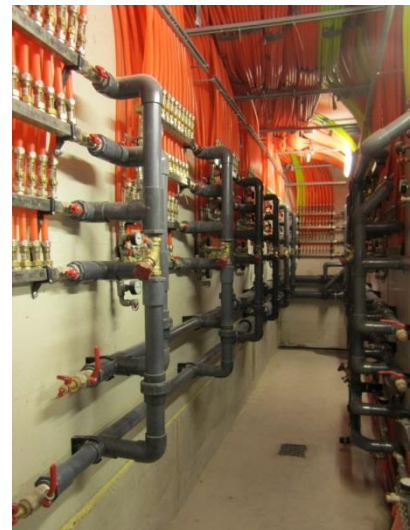
Abbildung 55: Ansicht der Heizzentrale bzw. der Wärmepumpen (linke Abbildung) und Darstellung der Verteiler und der Verrohrung der Rohrregister für den Erdspeicher (rechte Abbildung). Quelle: AIT
