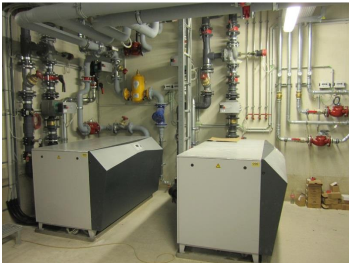
Abbildung 55: Ansicht der Heizzentrale bzw. der Wärmepumpen (linke Abbildung) und Darstellung der Verteiler und der Verrohrung der Rohrregister für den Erdspeicher (rechte Abbildung). Quelle: AIT
