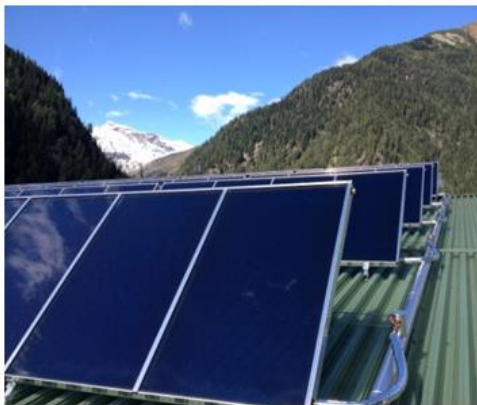
Abbildung 7: Detailaufnahme der Kollektorreihen (links, Bildquelle: Biowärme Mallnitz) sowie des 80 m 3 Pufferspeichers im Zuge der Errichtung (rechts, Bildquelle: Biowärme Mallnitz)
