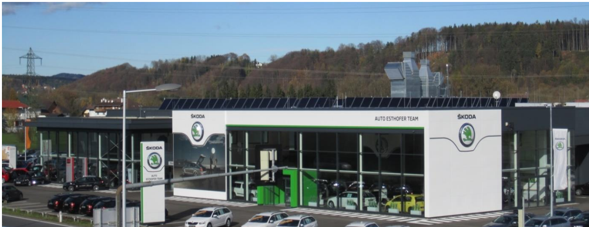
Abbildung 53: Südost-Ansicht des Gebäudes „Autohaus Esthofer“ mit den Kollektoren am Flachdach. Quelle: AIT
