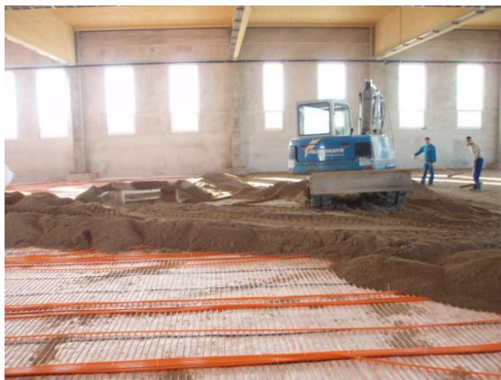
Abbildung 32: Verlegung und Endmontage der Rohrregister für den Erdspeicher (Bildquelle: AEE INTEC).
