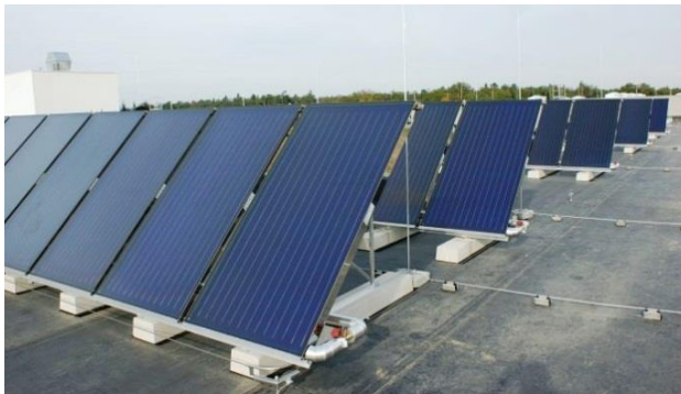
Abbildung 29: Aufständerung der Kollektorreihen am Dach des Büro- und Fertigungsgebäudes (linkes Bild). Pufferspeicher für Heizung und Warmwasserbereitung (rechtes Bild) (Bildquelle: AEE INTEC).
