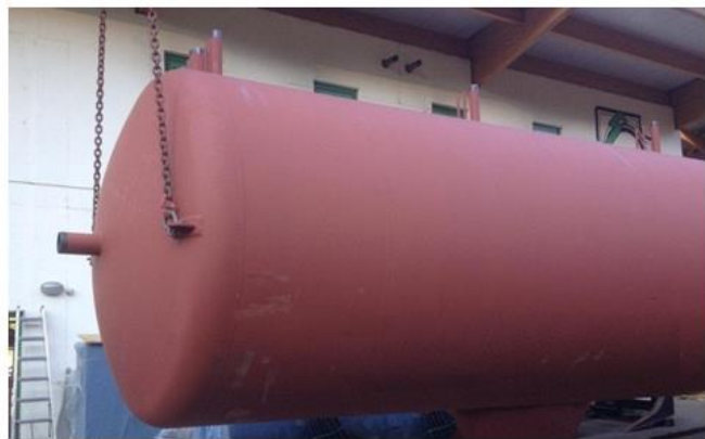
Abbildung 7: Detailaufnahme der Kollektorreihen (links, Bildquelle: Biowärme Mallnitz) sowie des 80 m 3 Pufferspeichers im Zuge der Errichtung (rechts, Bildquelle: Biowärme Mallnitz)
