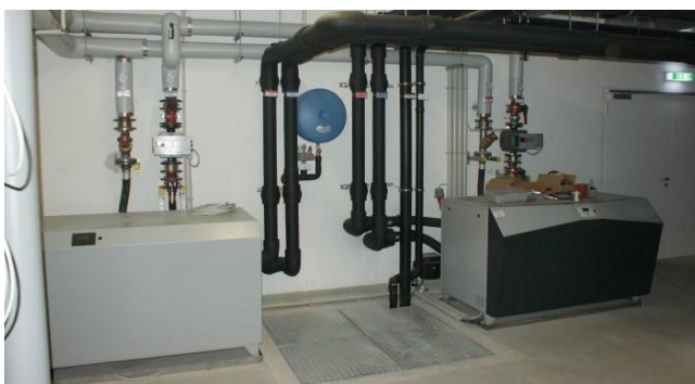
Abbildung 30: Wärmepumpen (linkes Bild); Verteiler und Verrohrung der Rohrregister für den Erdspeicher (rechtes Bild) (Bildquelle: AEE INTEC).
