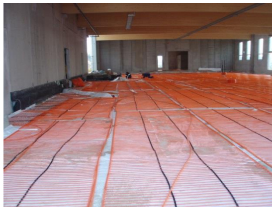
Abbildung 32: Verlegung und Endmontage der Rohrregister für den Erdspeicher (Bildquelle: AEE INTEC).
