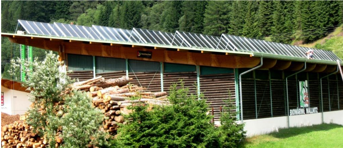
Abbildung 6: Ansicht des Heizwerks „Biowärme Mallnitz“ mit den aufgeständerten Kollektoren (Bildquelle: Hoval Gesellschaft m.b.H.)
