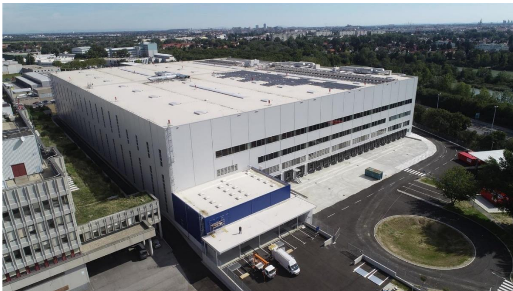
Abbildung 18: Neu errichtetes IKEA Logistik-Zentrum in Wien (Quelle: IKEA)
