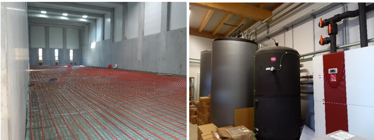
Abbildung 103: Verlegung der Bauteilaktivierung in der neu errichteten Halle (links), Pufferspeicher sowie Wärmepumpe (rechts) (Quelle: BG – Graspöintner)
