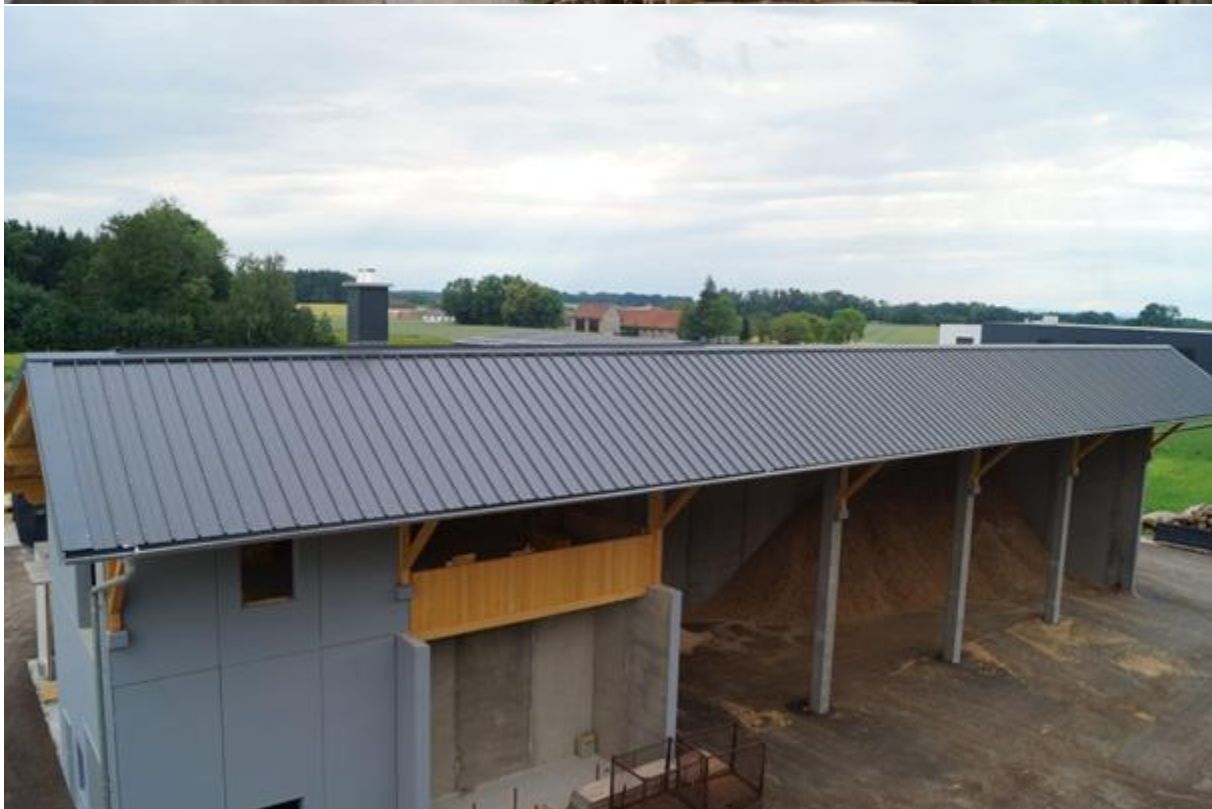
Abbildung 70: Süd- (oben) und Nordansicht (unten) der neu errichteten Halle inklusive Solaranlage am Dach (Quelle: Steinwendner GmbH)
