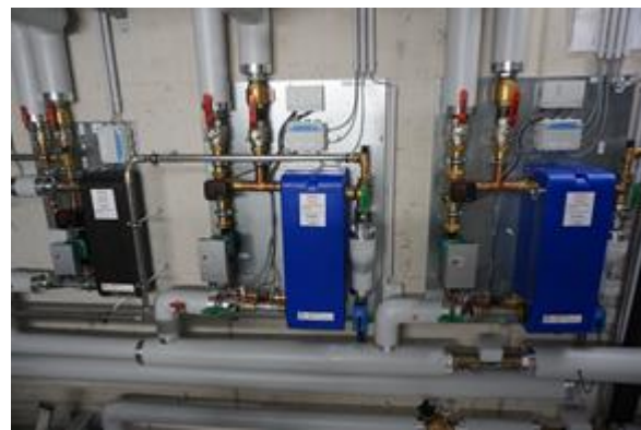
Abbildung 53: links: thermische Solaranlage am Dach, im Vordergrund eine 25 kWp PV-Anlage rechts: die drei parallel verschalteten Frischwassermodule (Quelle: AEE INTEC)
