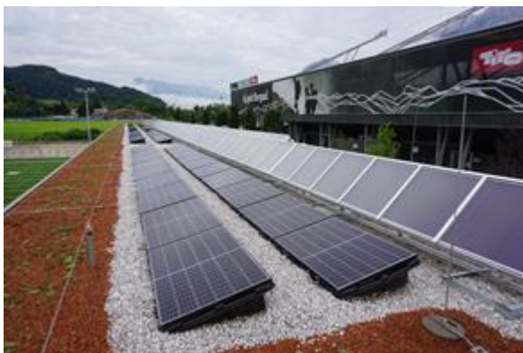
Abbildung 53: links: thermische Solaranlage am Dach, im Vordergrund eine 25 kWp PV-Anlage rechts: die drei parallel verschalteten Frischwassermodule (Quelle: AEE INTEC)
