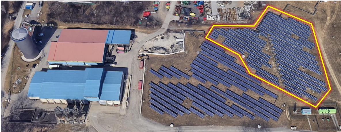
Abbildung 118: Bestehendes Kollektorfeld aus BA1 sowie das Kollektorfeld aus BA2 (gelb markiert), am linken Bildrand ist der 2500 m 3 große Pufferspeicher abgebildet. (Quelle: maps.google.at)
