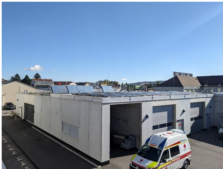
Abbildung 86: Solaranlage auf dem Dach der Fahrzeughalle (Quelle: AEE INTEC)
