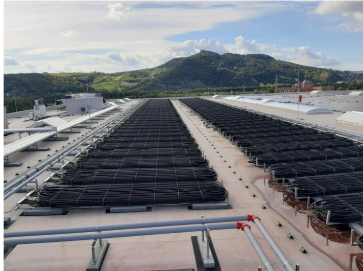
Abbildung 17: Bau des Eisspeichers (links, Quelle: IKEA), ungedeckte Absorbermatten sowie Photovoltaik-Anlage am Dach der Anlage Logistikzentrum IKEA (rechts) (Quelle: AEE INTEC)
