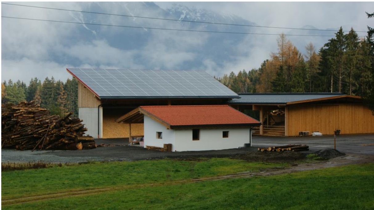
Abbildung 7: Südansicht der Trocknungsanlage der Regionalenergie Natters eGen (Quelle: AEE INTEC)
