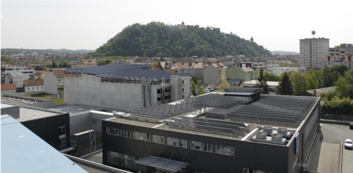
Abbildung 55: Rendering der Kollektorfelder AVL I und AVL II. Im Vordergrund das 1.295 m 2 große Kollektorfeld am Dach des APZ-Gebäudes (AVL II) bzw. im Hintergrund das 1.585 m 2 große Kollektorfeld am Dach der Parkgarage (AVL I). (Bildquelle: SOLID Solar Energy Systems)
