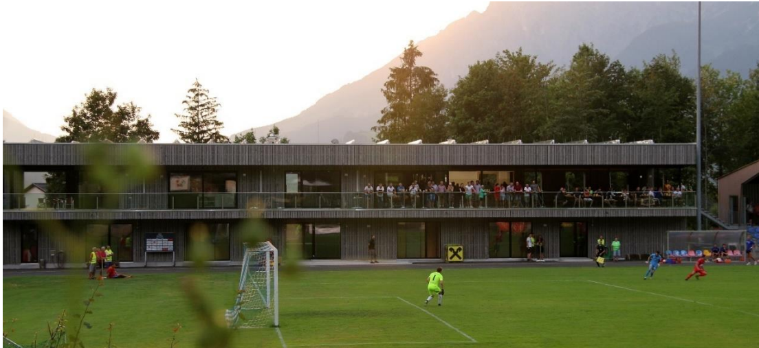
Abbildung 21: Ansicht der Sportanlage mit den aufgeständerten Kollektoren am Dach (Quelle: Stadtamt Saalfelden)
