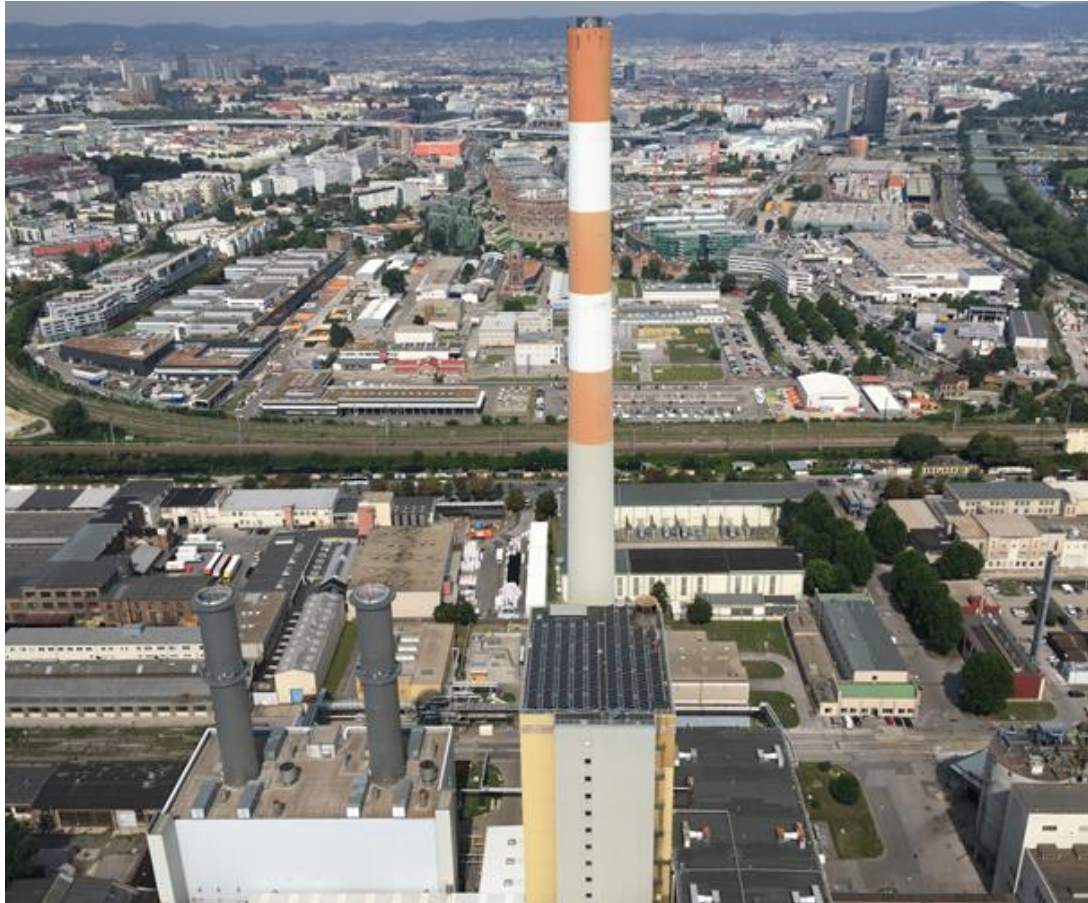
Abbildung 44: Solaranlage auf dem Dach des Kesselhausgebäudes in Wien Simmering (Quelle: GREENoneTEC)
