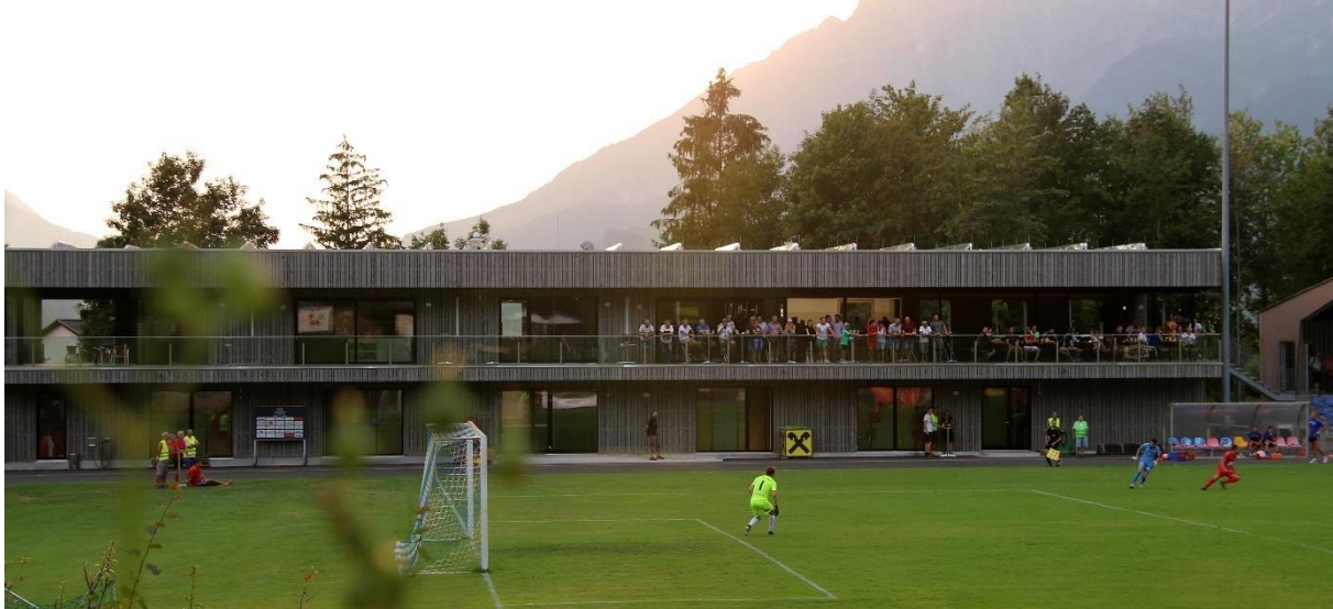
Abbildung 10: Ansicht der Sportanlage mit den aufgeständerten Kollektoren am Dach (Quelle: Stadtamt Saalfelden)
