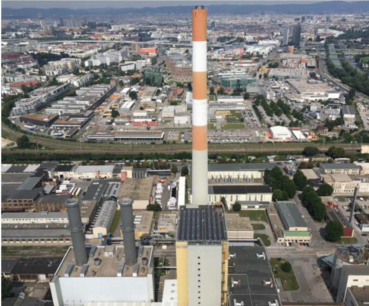
Abbildung 16: Solaranlage auf dem Dach des Kesselhausgebäudes in Wien Simmering (Quelle: GREENoneTEC)
