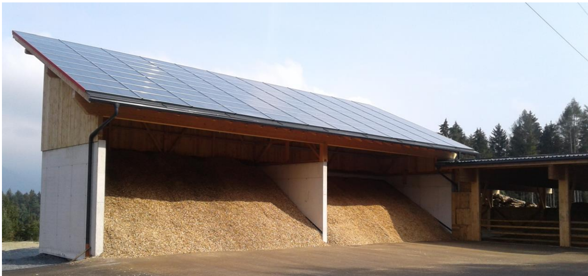
Abbildung 6: Südansicht der Trocknungsanlage der Regionalenergie Natters eGen (Quelle: Bauherr)
