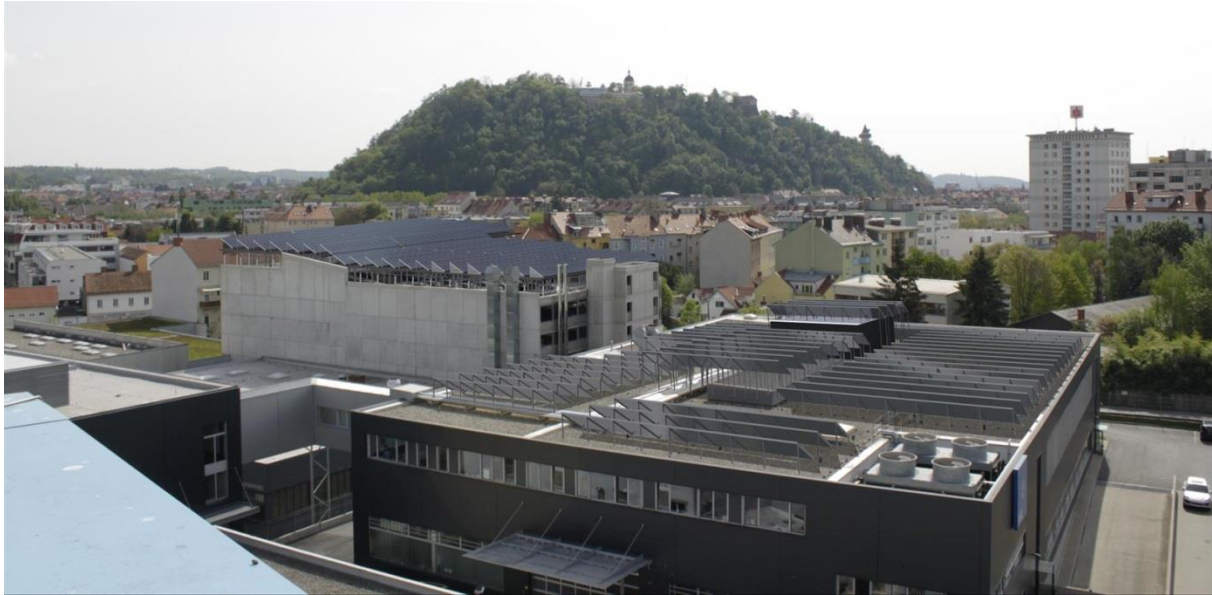
Abbildung 19: Rendering der Kollektorfelder AVL I und AVL II. Im Vordergrund das 1.400 m 2 große Kollektorfeld am Dach des APZ-Gebäudes (AVL II) bzw. im Hintergrund das 1.580 m 2 große Kollektorfeld am Dach der Parkgarage (AVL I). (Bildquelle: S.O.L.I.D. Gesellschaft für Solarinstallation und Design m.b.H.)
