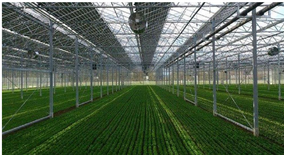
Abbildung 7: Teil-belegtes Dach mit semi-transparenten PV-Module
