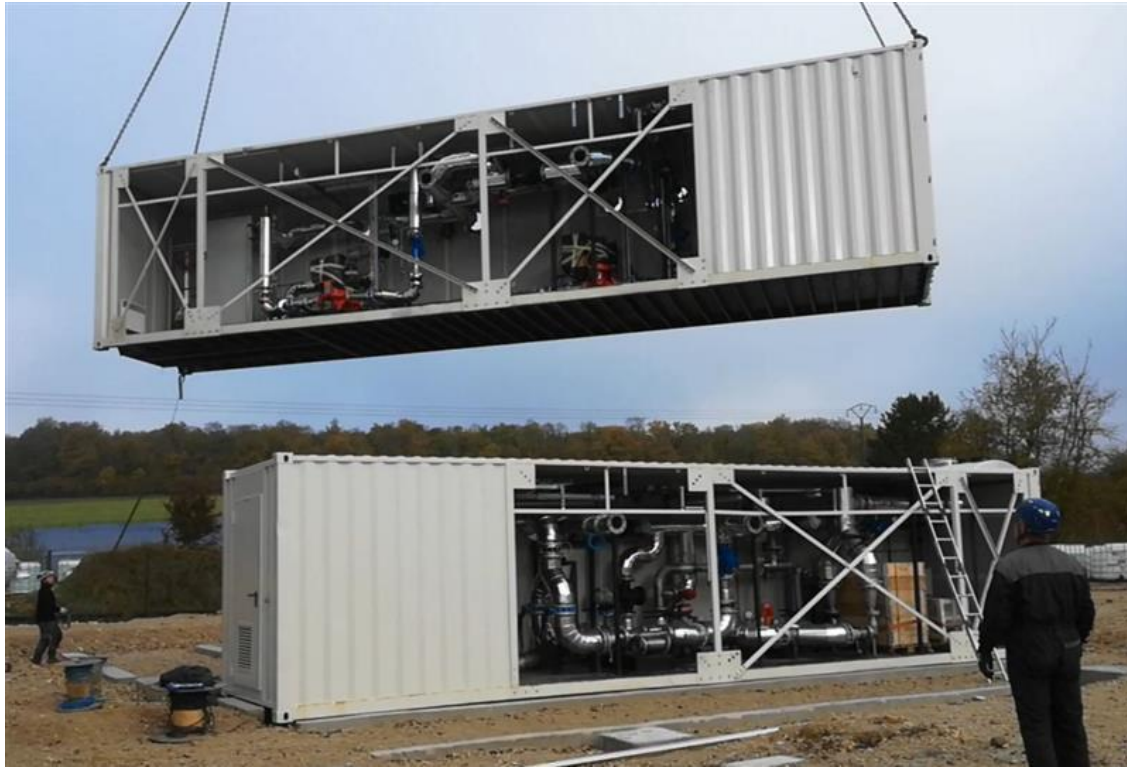
Abbildung 15: Vormontierte/-geprüfte Solarstation DN150 in Containerbauweise
