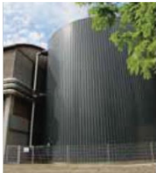
Abbildung 10: 2 x 100 m 3 Druckspeicher vs. 1.000 m 3 druckloser Speicher (selbe Bauhöhe)
