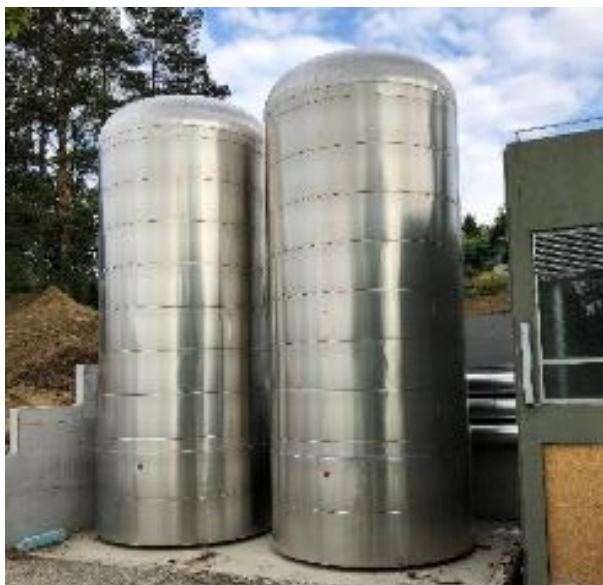
Abbildung 10: 2 x 100 m 3 Druckspeicher vs. 1.000 m 3 druckloser Speicher (selbe Bauhöhe)
