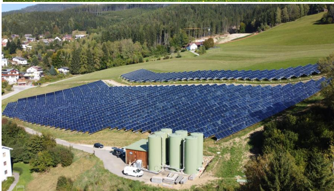
Abbildung 11: Impressionen von der fertiggestellten Anlage
