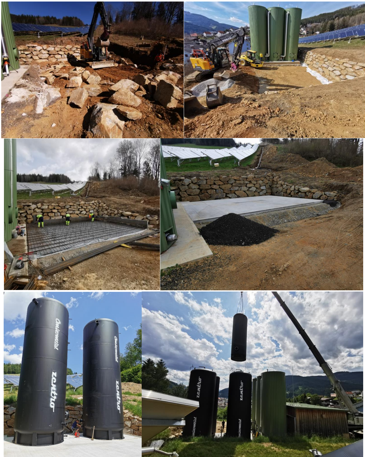
Abbildung 7: Errichtung der Steinschichtung, des Fundamentes und der Pufferspeicher
