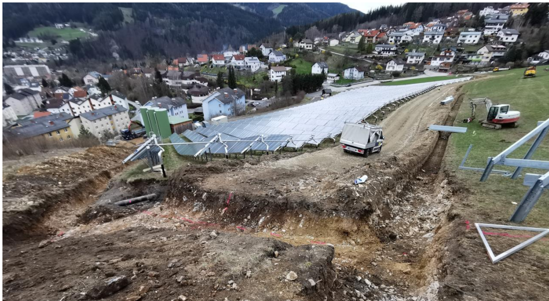
Abbildung 1: Errichtung der Bau- und Wartungsstraße sowie der Künette für die Erdleitungen
