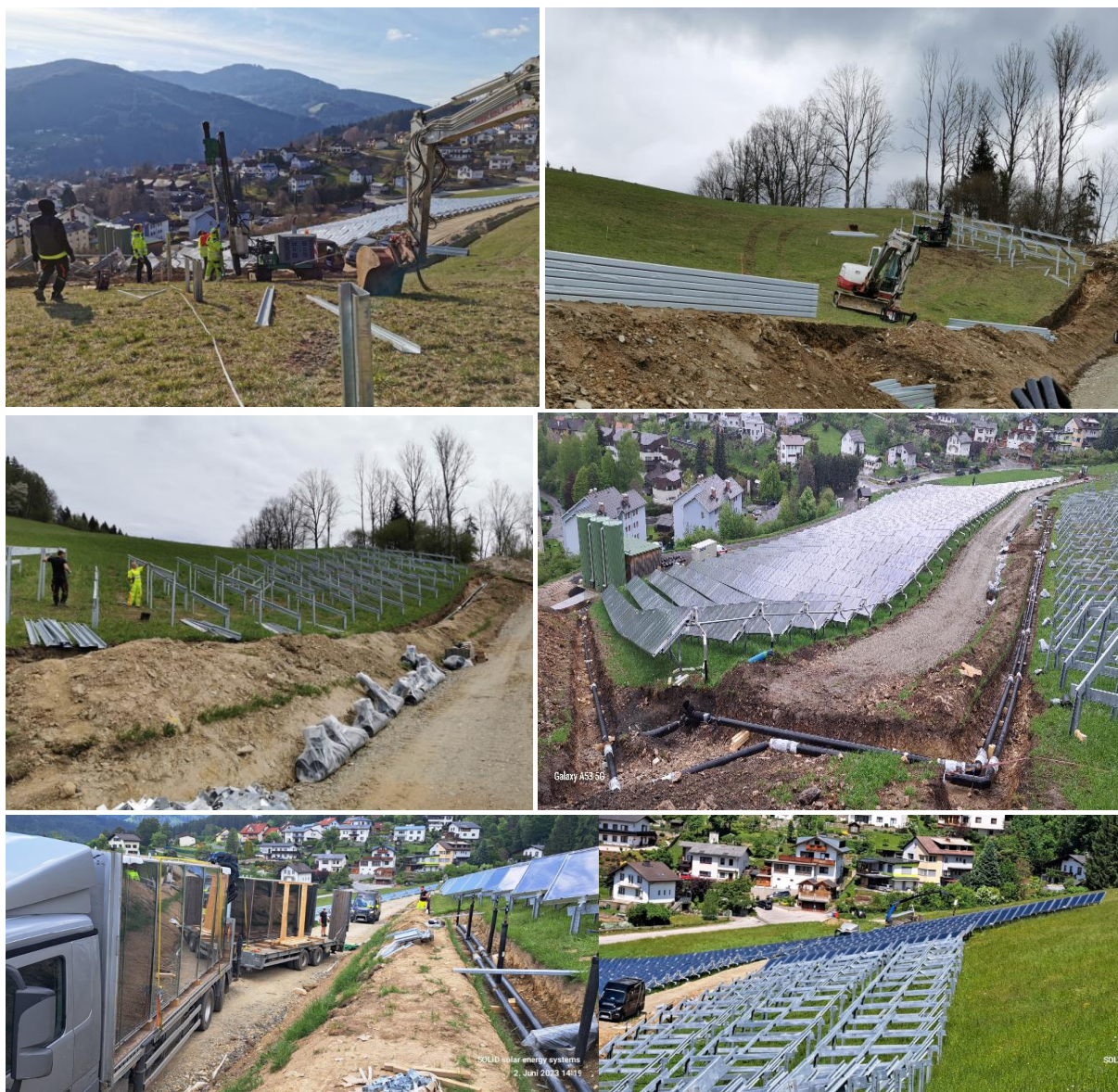
Abbildung 4: Bauphasen von der Errichtung des Kollektorfeldes
