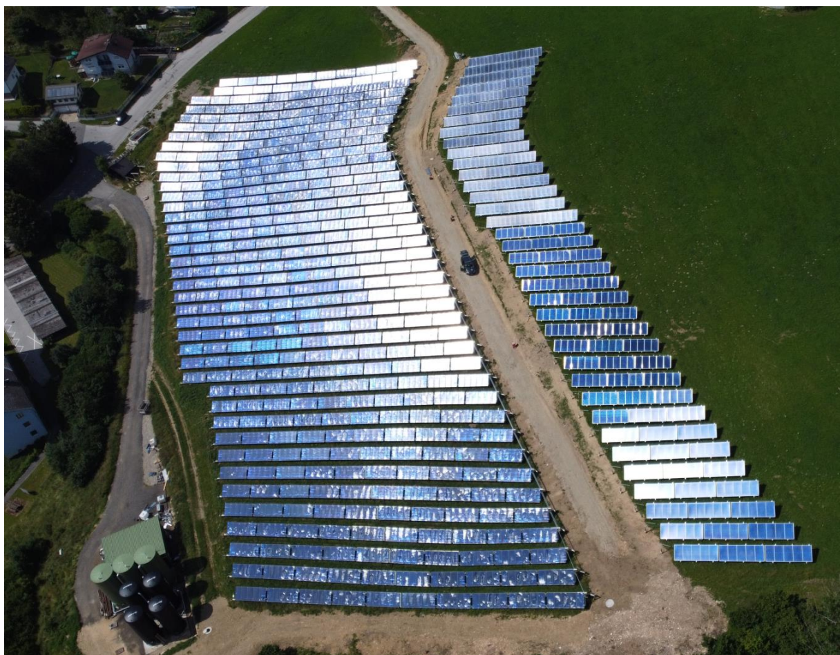
Abbildung 6: Luftbild des fertiggestellten Kollektorfeldes
