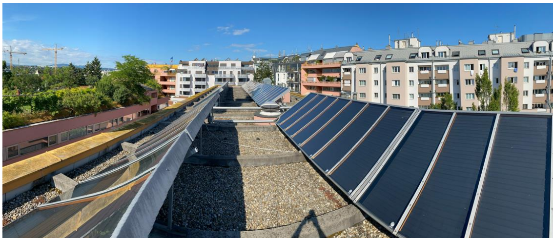
Bestandsanlage – Ansicht vorne - Optimierungsmeeting
