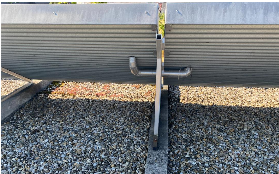
Bestandsanlage – Ansicht hinten - Optimierungsmeeting
