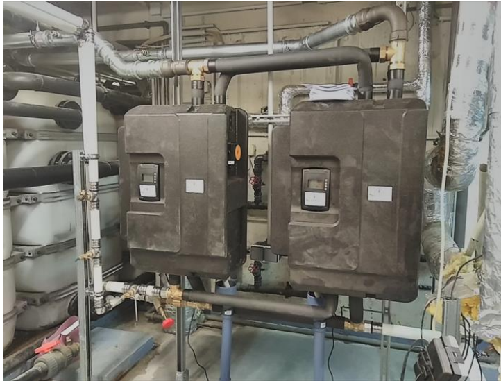
Erneuerte Warmwassermodule
