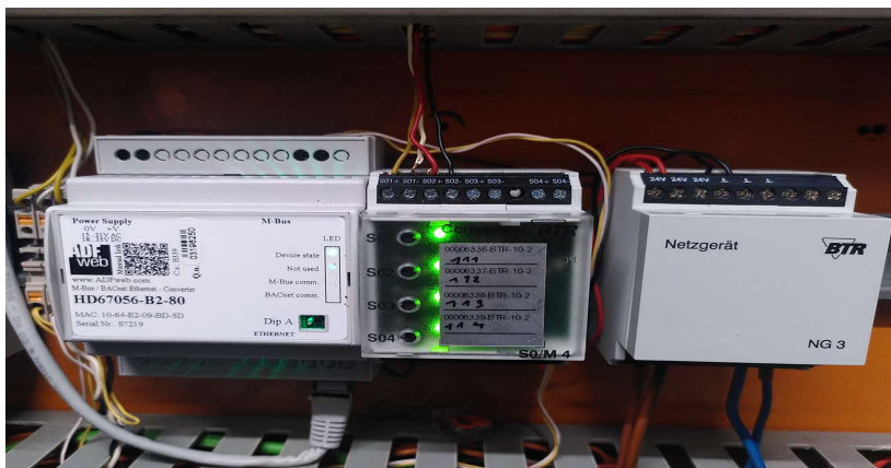
Abbildung 6: M-Bus Gateway für 20 M-Bus Teilnehmer
