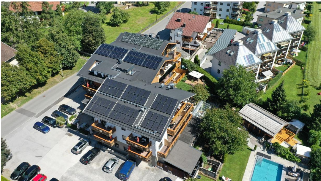
Abbildung 15: Luftbild von Hotel Riederhof, PVT Kollektoren, Solarthermie Flachkollektoren, PV-Anlage (von unten nach oben) (Quelle: 3F-Solar)
