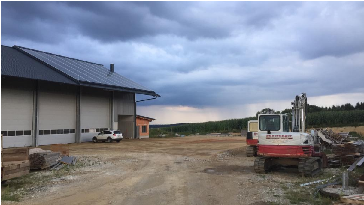
Abbildung 5: Kollektoranlage am Dach der Trocknungshalle (Quelle: T. Dachs)
