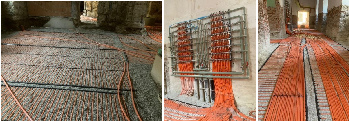
Abbildung 10: Erdspeicher im Erdgeschoß
