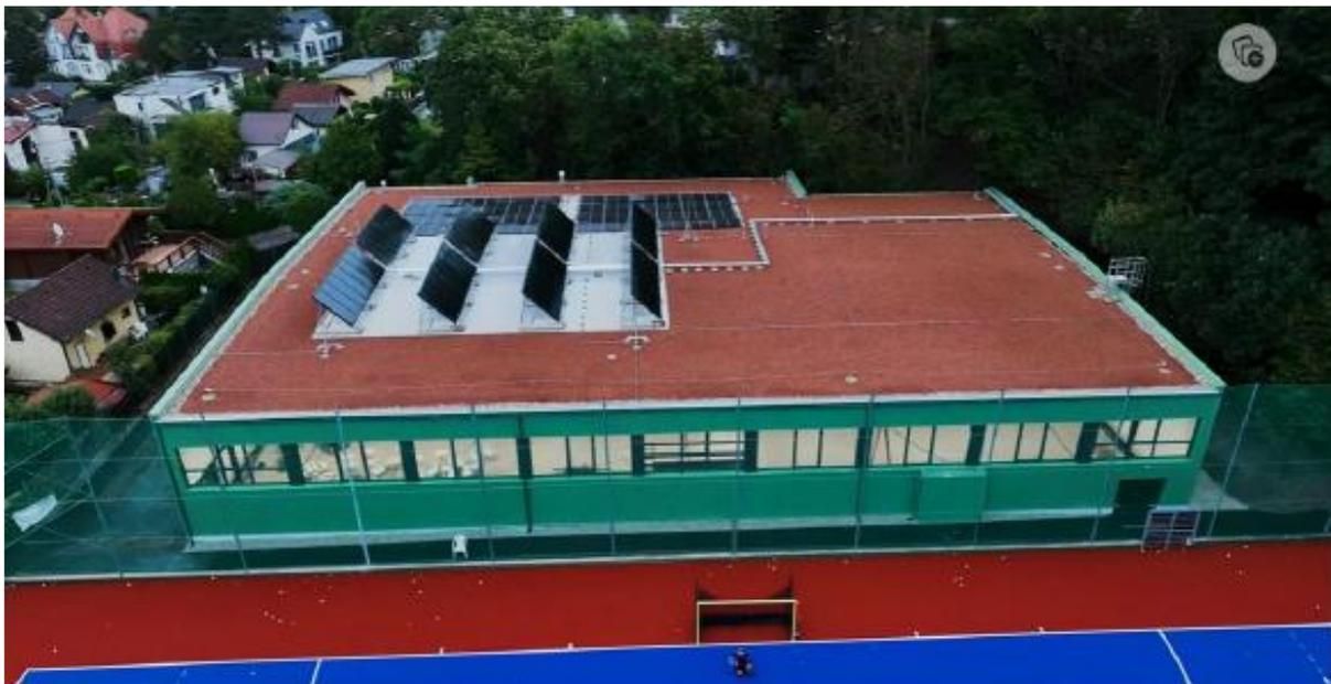
Die Beheizung der Landhockeyhalle sowie die Warmwasserbereitung für die Sanitärgruppen erfolgt mit einer Sole/Wasser-Wärmepumpe in Kombination mit einer thermischen Solaranlage (129 m<sup>2</sup>) und einem Spitzenlastkessel.
