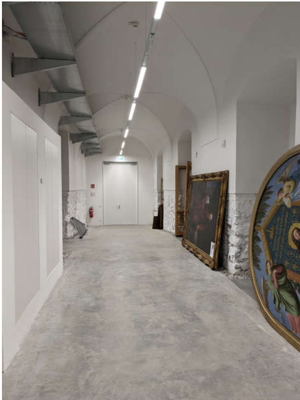
Abb. 02,03,04: baulich fertig gestellte Gänge und Räumlichkeiten im EG
