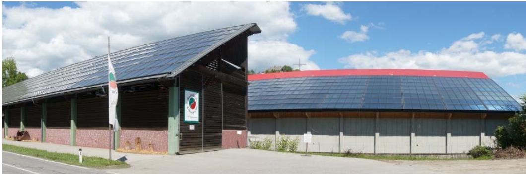
Abbildung 30: Ansicht der beiden Kollektorfelder als Panoramafoto (links: 1.250 m 2 Altbestand; rechts: 1.200 m 2 Neubau) der Anlage „Nahwärme Eibiswald“, Bildquelle: AEE INTEC
