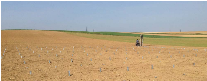
Abbildung 34: Montage der Stahlanker für die Aufnahme der Kollektoren am Betriebsareal (linke Abbildung, Bildquelle: ÖKOTECH) sowie beispielhafte Abbildung eines für die Montage des Kollektorfeldes verwendeten Stahlankers (rechte Darstellung, Bildquelle: terrafix)
