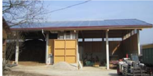
Abbildung 38: Ansicht der Anlage Wührer Holzrocknung, OÖ, mit 480m 2 Luftkollektor und 85 Tonnen Steinspeicher (Bildquelle: AIT)
