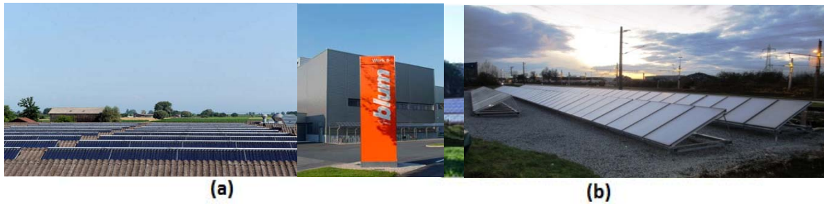
Abbildung 10: (a) Beschlägefabrik Blum, Vlbg. (460m 2 , 16 m 3 Wasserspeicher, SD: 6%, SE: 442 kWh/m 2 a). (b) Fixkraft Kraftfutter, OÖ (324 m 2 , 6m 3 Wasserspeicher, SE: 343 kWh/m 2 a); Bildquellen: Ritter XL Solar (Blum), AEE INTEC (Fixkraft)
