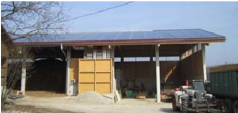
Abbildung 14: Wührer Holztrocknung, OÖ, mit 480m 2 Luftkollektor und 85 Tonnen Steinspeicher (Bildquelle: AIT)
