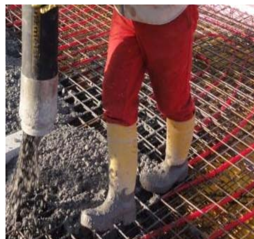
Abbildung 44: Beispielhafte Darstellung zur Herstellung eines thermisch aktivierbaren Bauteils (Bildquelle: salzburg.com)
