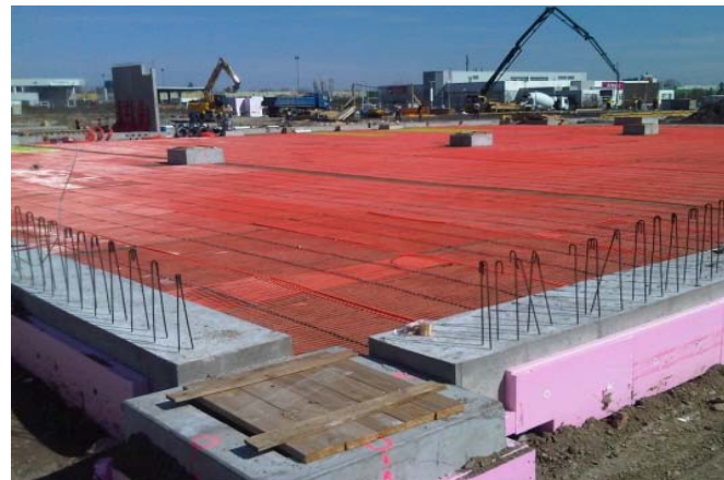
Abbildung 42: Ansicht des Rohrregisters vor Hinterfüllung des Erdspeichers unter dem Gebäude (Bildquelle: AIT)
