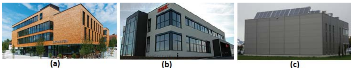
Abbildung 6: (a) Sternenhôtel Wolfurt, Vbg. (167m 2 , 5m 3 Wasser; SD: 15%, SE: 356 kWh/m 2 a). (b) Stihl Motorsägen Vertriebsareal, NÖ (257m 2 , 8m 3 Wasser; 5000m 2 Erdspeicher, SD: 13% (ohne Erdspeicher), SE: 348 kWh/m 2 a). (c) ETG Sonnenhaus, Vbg. (121m 2 , 8m 3 Wasser; Bodenplatte, SD: 97%, SE: 213kWh/m 2 a); alle Bildquellen: AIT
