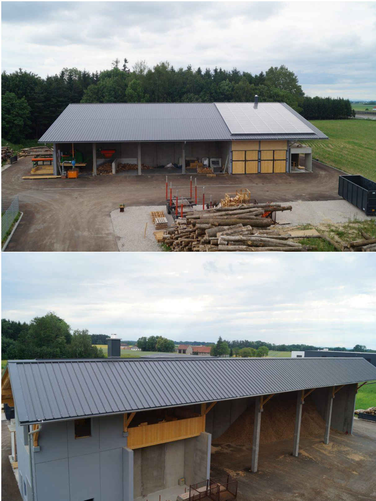
Abbildung 18: Süd- (oben) und Nordansicht (unten) der neu errichteten Halle inklusive Solaranlage am Dach (Quelle: Steinwendner GmbH)
