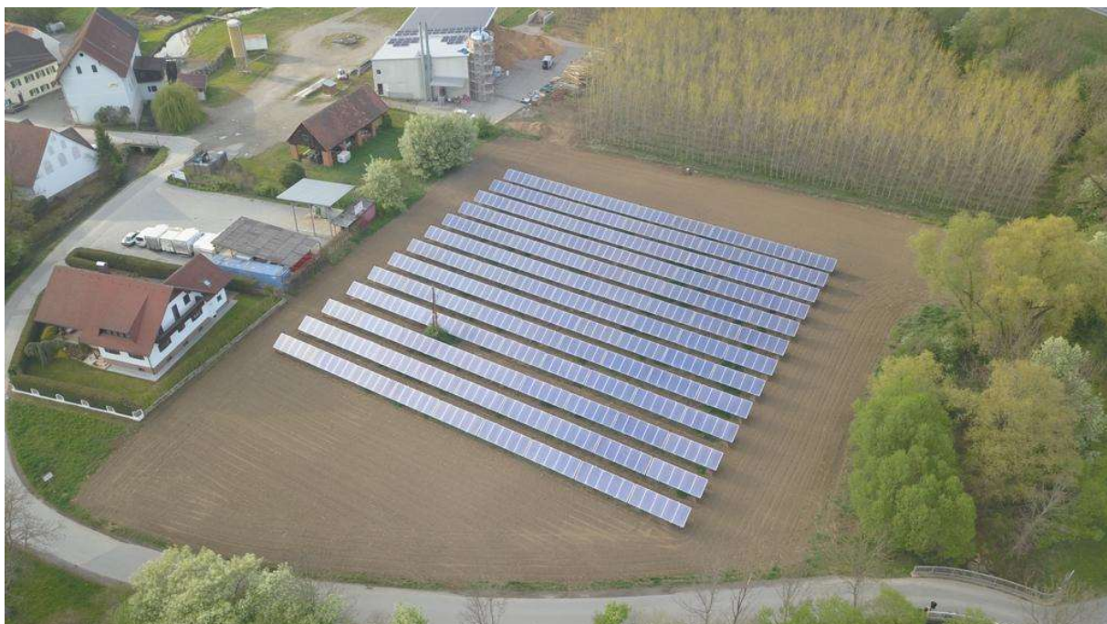
Abbildung 2: Luftaufnahme der errichteten 1.590 m 2 Kollektorfläche
