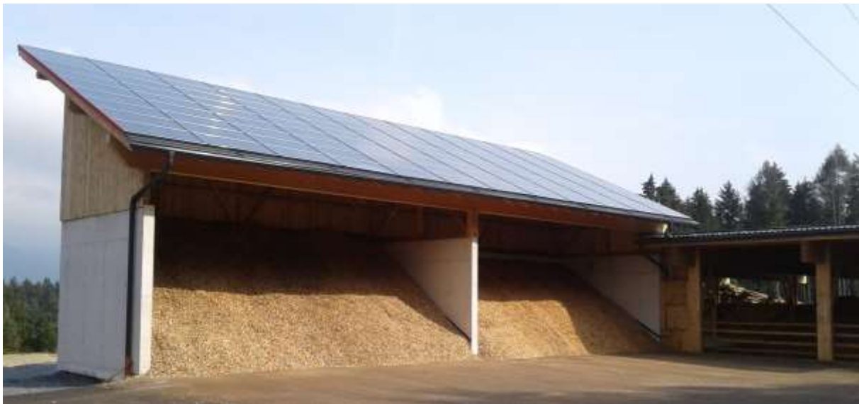
Abbildung 7: Südansicht der Trocknungsanlage der Regionalenergie Natters eGen (Quelle: Bauherr)
