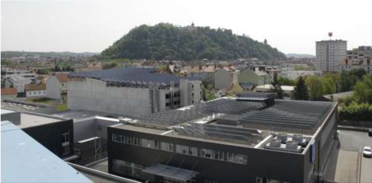
Abbildung 51: Rendering der Kollektorfelder AVL I und AVL II. Im Vordergrund das 1.400 m 2 große Kollektorfeld am Dach des APZ-Gebäudes (AVL II) bzw. im Hintergrund das 1.580 m 2 große Kollektorfeld am Dach der Parkgarage (AVL I). (Bildquelle: S.O.L.I.D. Gesellschaft für Solarinstallation und Design m.b.H.)
