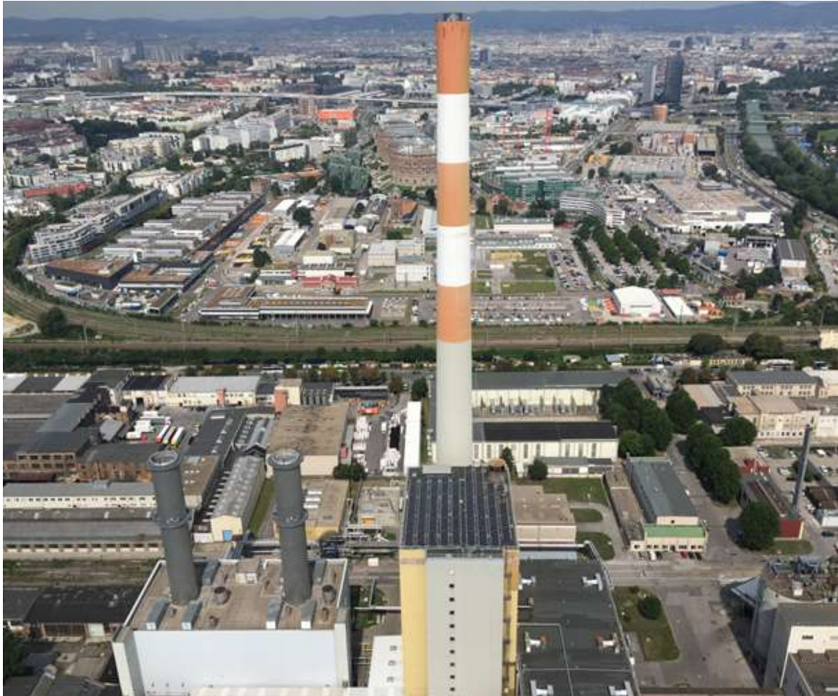
Abbildung 40: Solaranlage auf dem Dach des Kesselhausgebäudes in Wien Simmering (Quelle: GREENoneTEC)
