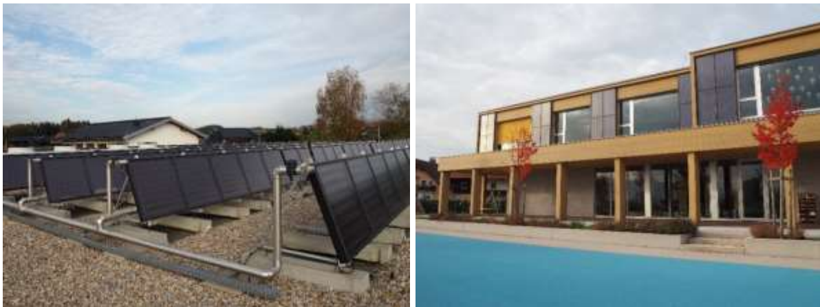
Abbildung 103: Aufstellung der Flachkollektoren am Dach (70°, links) und Integration der Kollektoren in die Fassade (90°, rechts) (Quelle: AEE INTEC)
