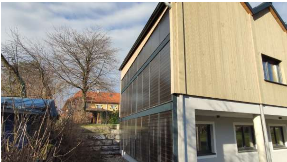
Abbildung 146: Verschattung der Fassadenkollektoren, 8.1.2020 12:04 (Quelle: GRT GmbH)
