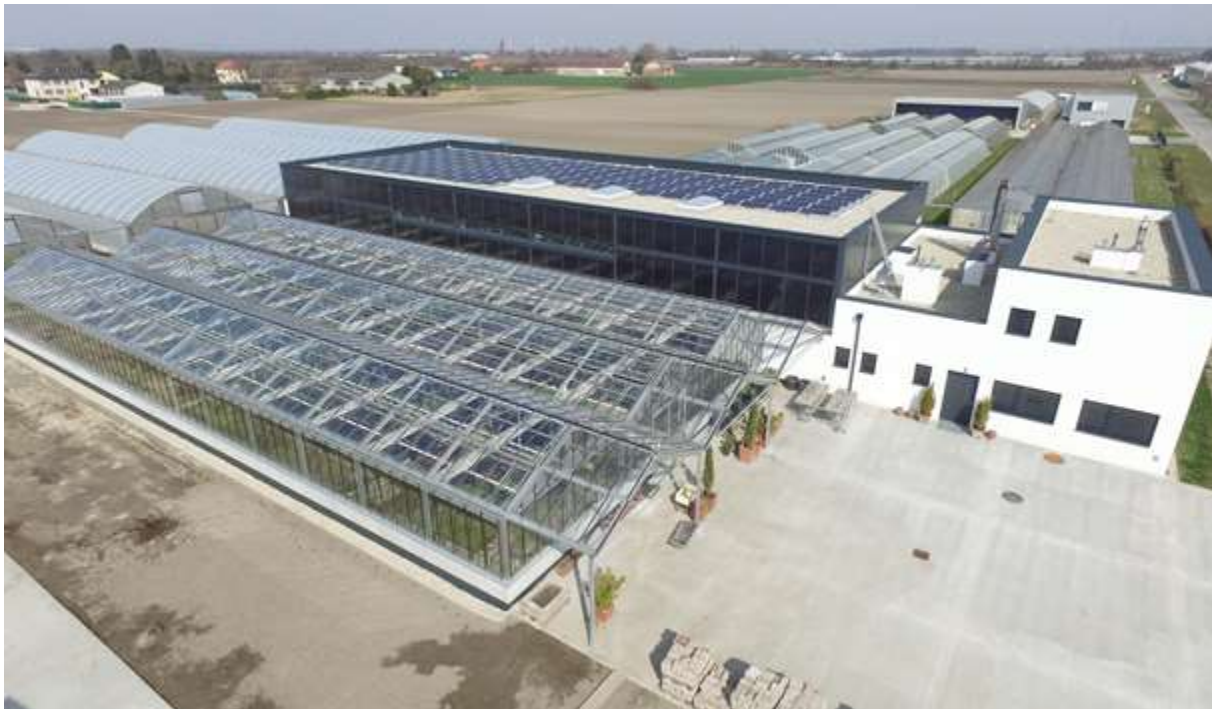
Abbildung 49: Südansicht der Gärtnererei Bach. Im Vordergrund die mit Bauteilaktivierung beheizten Glashäuser. Die Solaranlage ist in die Fassade integriert. Am Dach ist eine PV-Anlage installiert (Quelle: Bauherr)
