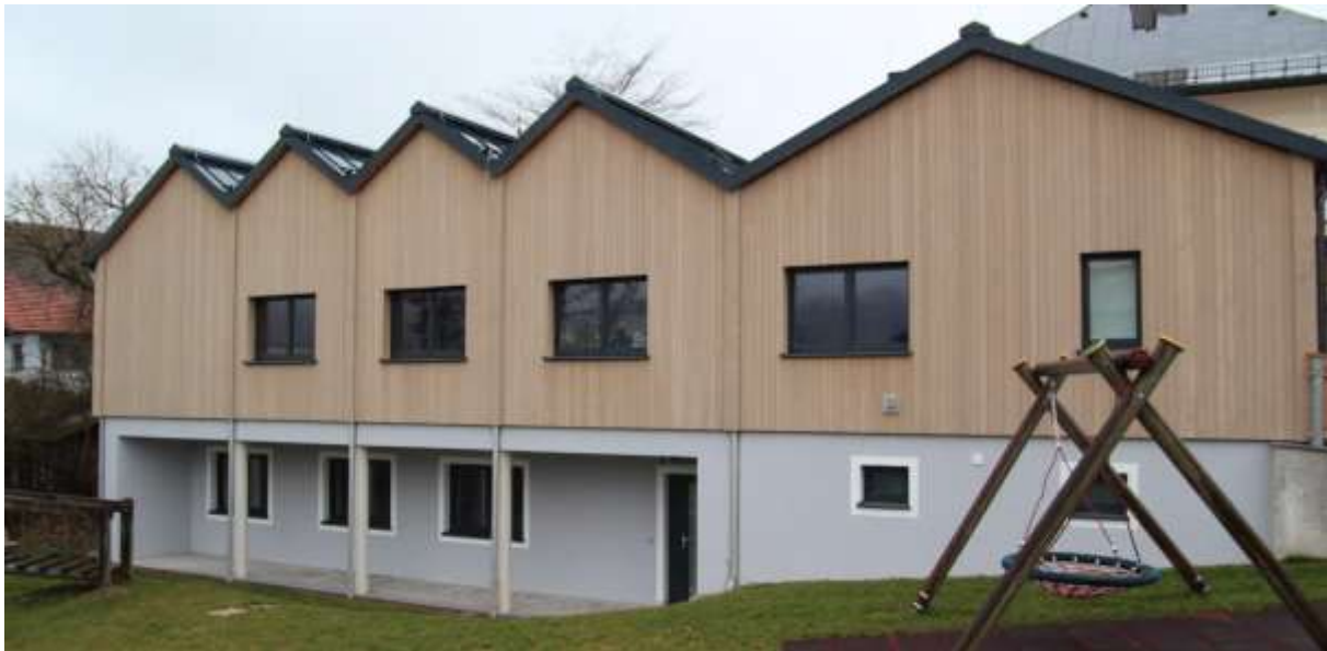
Abbildung 133: Ansicht des Erweiterungsbaus Pfarrhof St. Martin (Quelle: AIT)
