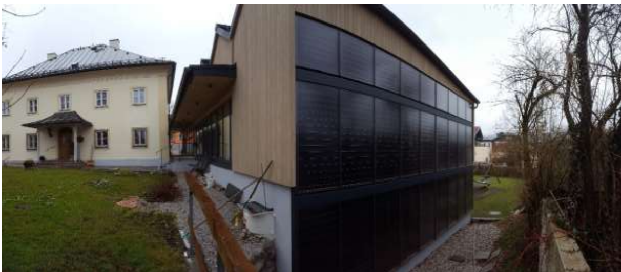
Abbildung 135: Ansicht des Erweiterungsbaus (rechts) Pfarrhof St. Martin mit Bestandsgebäude (links)(Quelle: AIT)
