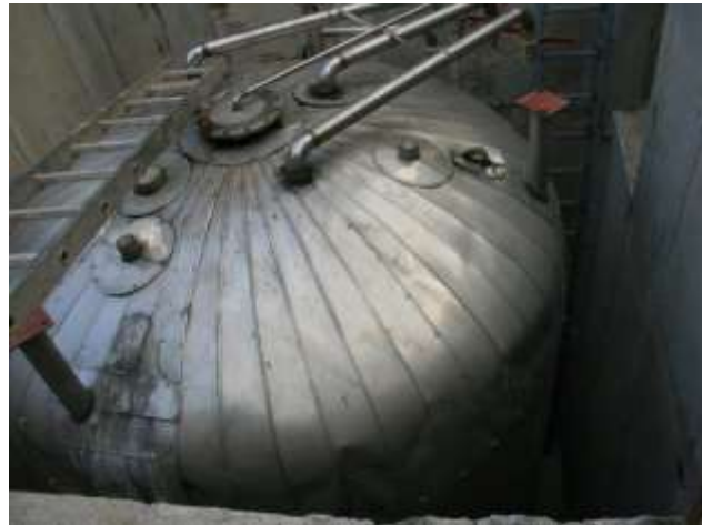
Abbildung 188: Darstellung des 30 m 3 Pufferspeicher während der Errichtung auf dem Betriebsgelände des landwirtschaftlichen Betriebs Schickmaier (Quelle: Schickmaier).
