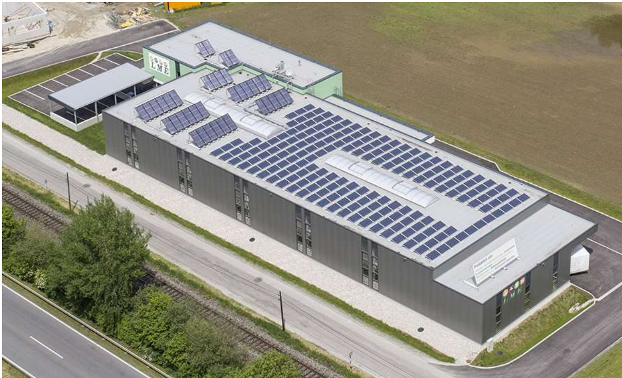
Abbildung 62: LME Produktionshalle mit Solarthermie-Kollektoren (im Bild links) und Photovoltaikmodulen (im Bild rechts). Quelle: LME
