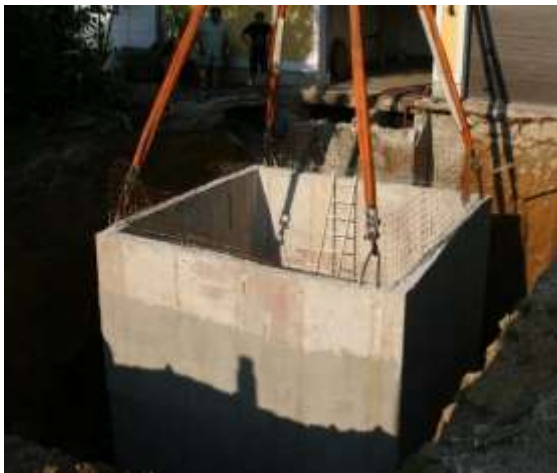
Abbildung 188: Darstellung des 30 m 3 Pufferspeicher während der Errichtung auf dem Betriebsgelände des landwirtschaftlichen Betriebs Schickmaier (Quelle: Schickmaier).
