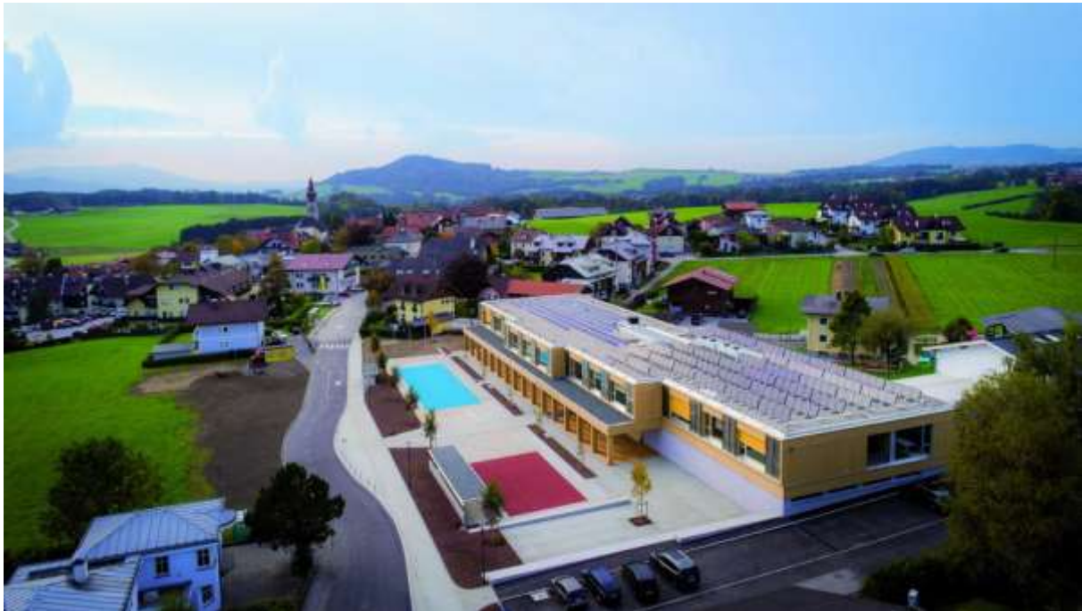
Abbildung 102: Südost Ansicht der Volksschule Hallwang – die Fassadenkollektoren sind neben den Fenstern montiert, das Dach wurde sowohl für die Solarthermie- als auch für eine Photovoltaik-Anlage genutzt (Quelle: Gemeinde Hallwang)
