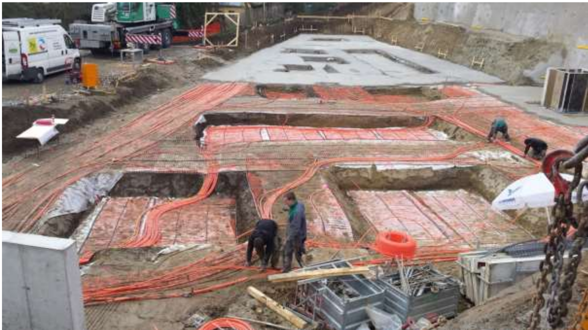
Abbildung 31: Erdspeicher während der Bauphase (Bildquelle: BES GmbH)
