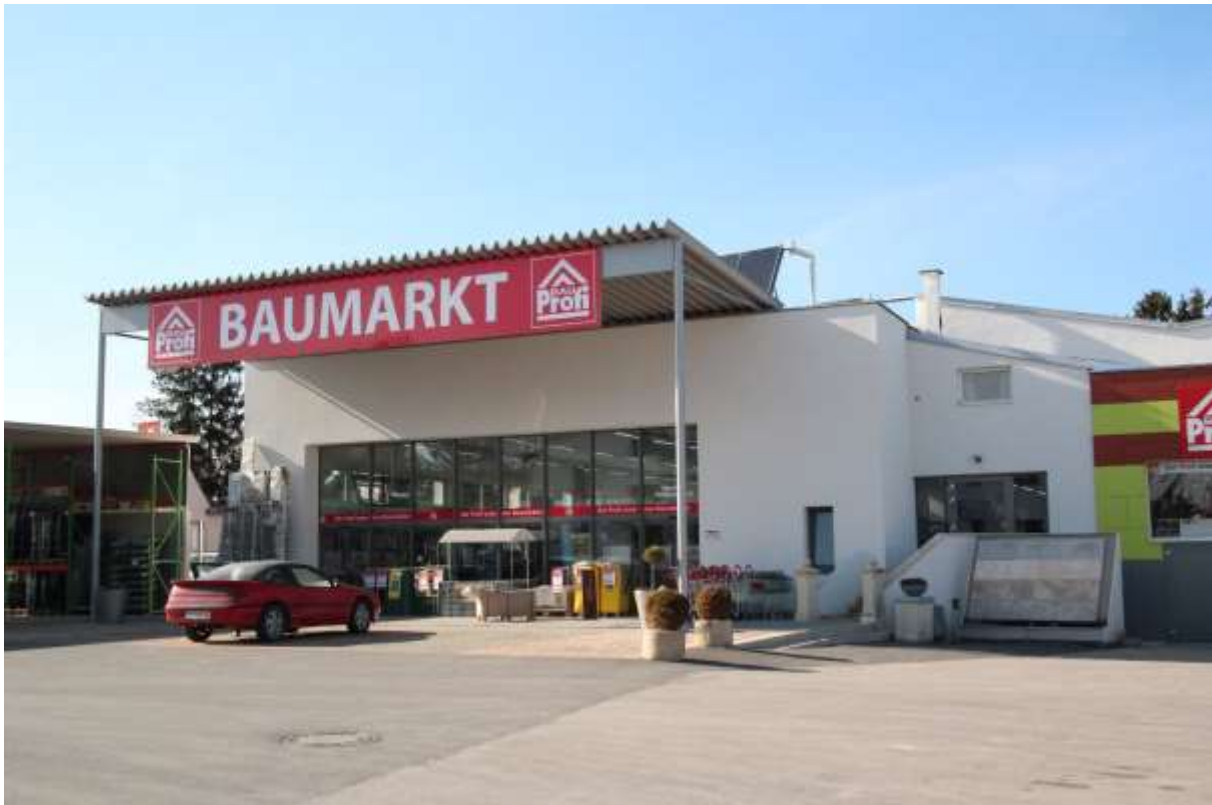
Abbildung 6: Ansicht des Eingangsbereichs (Südostansicht, Quelle: AIT)
