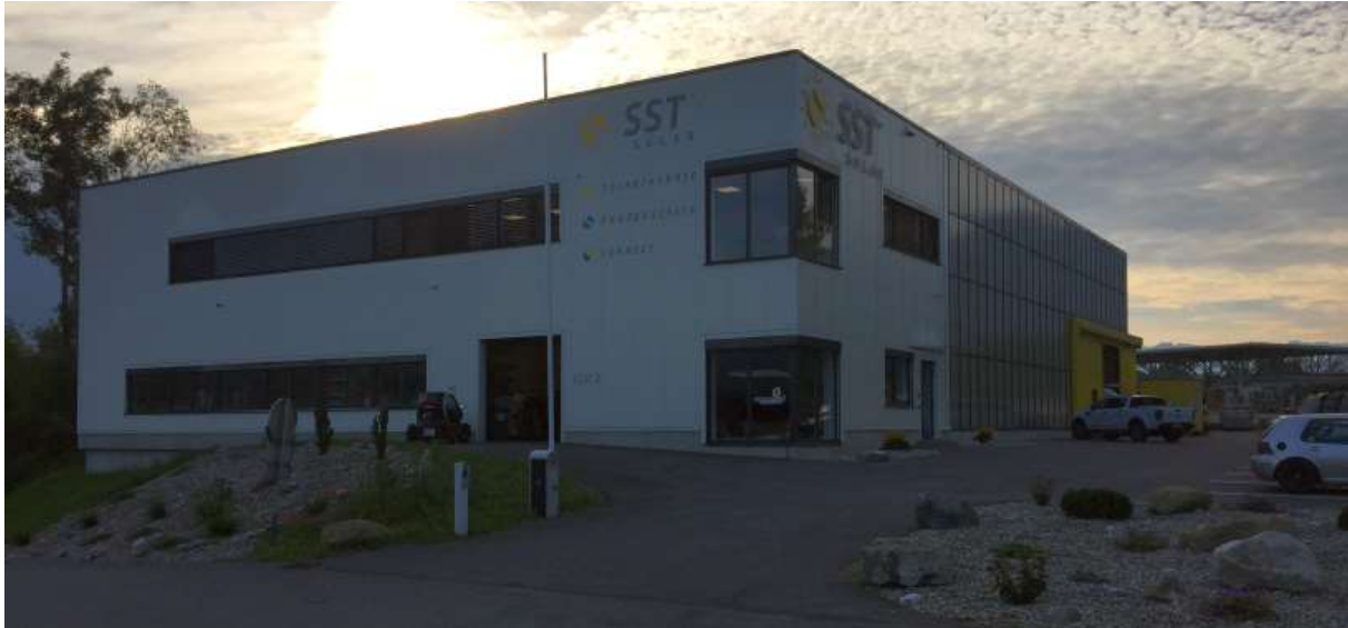
Abbildung 151: Ansicht des Neubaus von SST Solar GmbH – südwestliche Solaranlage in der Fassade sichtbar (Bildquelle: AEE INTEC)
