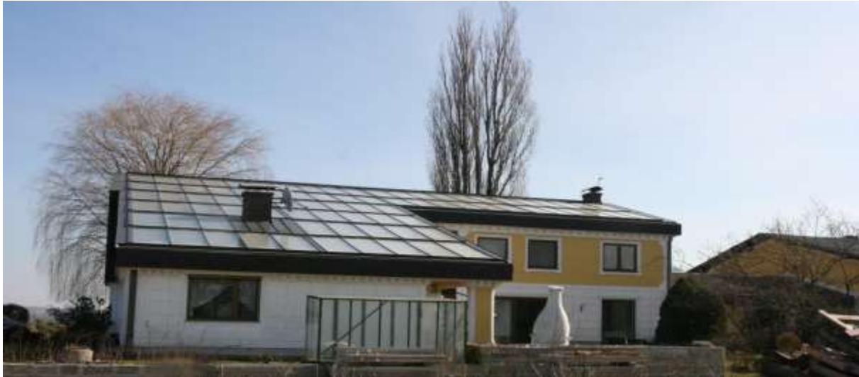
Abbildung 187: Ansicht des Wirtschaftsgebäudes bzw. des Kollektorfeldes der Anlage „Solare Trocknung Schickmaier“ (rechte Abbildung) sowie Ansicht des 30 m 3 Pufferspeichers während der Installation im Jänner 2015 (linke Abbildung) (Quelle: Schickmaier).
