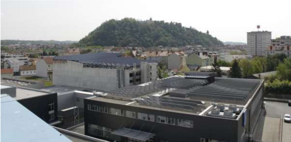
Abbildung 166: Rendering der Kollektorfelder AVL I und AVL II. Im Vordergrund das 1.295 m 2 große Kollektorfeld am Dach des APZ-Gebäudes (AVL II) bzw. im Hintergrund das 1.585 m 2 große Kollektorfeld am Dach der Parkgarage (AVL I). (Bildquelle: SOLID Solar Energy Systems)
