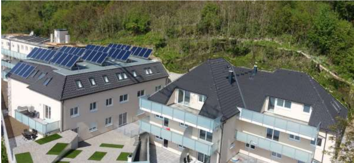
Abbildung 30: Ansicht der Anlage „Fuxsteiner & Heimberger OG“ (Bildquelle: HEIFU Immobilien GmbH)
