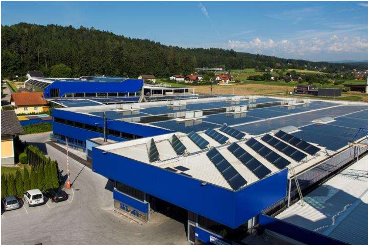
Abbildung 157: Ansicht des Betriebsgeländes der Fa. SFL technologies GmbH. Im vorderen Teil ist das Kollektorfeld am Flugdach der bestehenden Fassadenbauhalle (Bildquelle: Firma H. Traussnigg GmbH).
