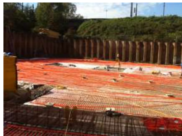
Abbildung 31: Ansicht des Rohrregister und Verrohrung der Rohrregister für den Erdspeicher im Zuge der Errichtung (Bildquelle: BES)
