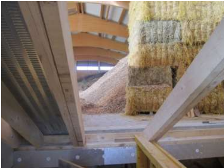
Abbildung 217: Ansicht von unten des zum Zeitpunkt der Aufnahme noch in Bau befindlichen Schrägrosts. Quelle: AIT
