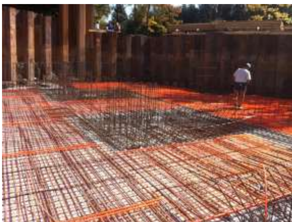
Abbildung 31: Ansicht des Rohrregister und Verrohrung der Rohrregister für den Erdspeicher im Zuge der Errichtung (Bildquelle: BES)
