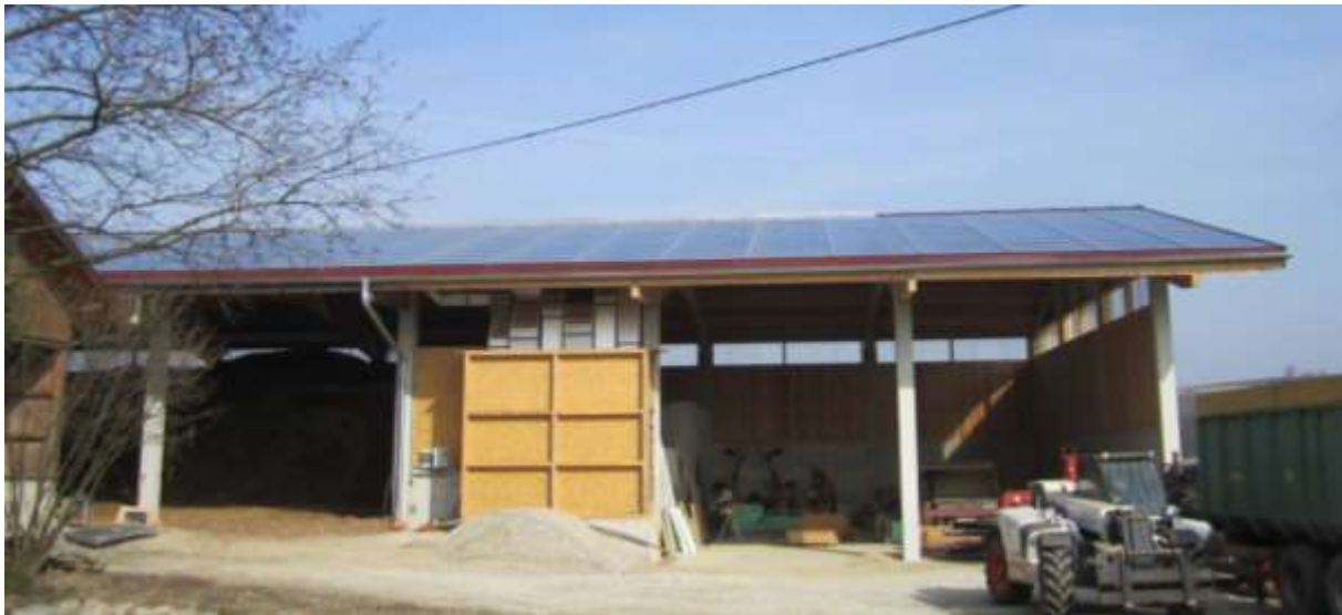
Abbildung 212: Süd-Ansicht der Halle mit der Luftkollektoranlage. Quelle: AIT
