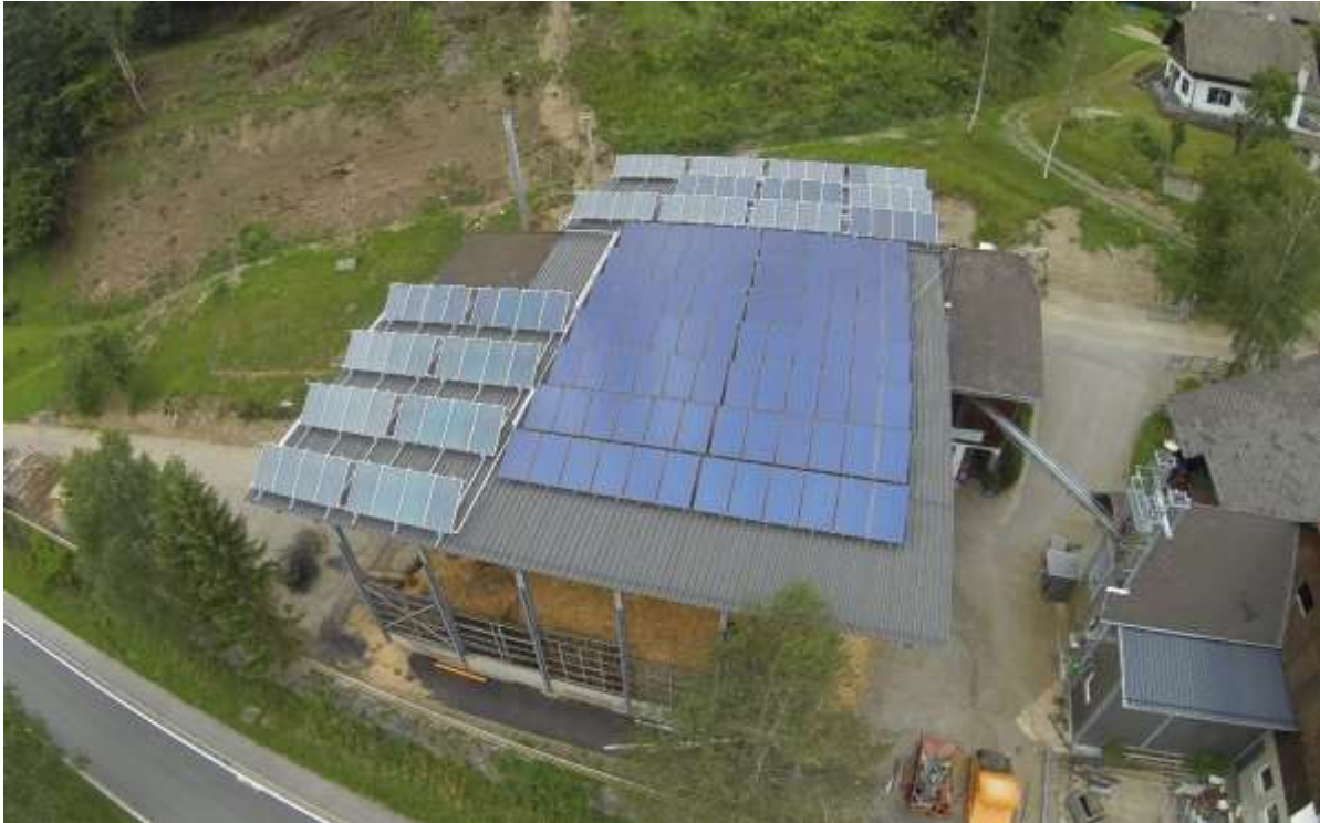
Abbildung 143: Nahwärme Sirnitz mit Solarthermiekollektoren. Quelle: ZÜRNER technologies
