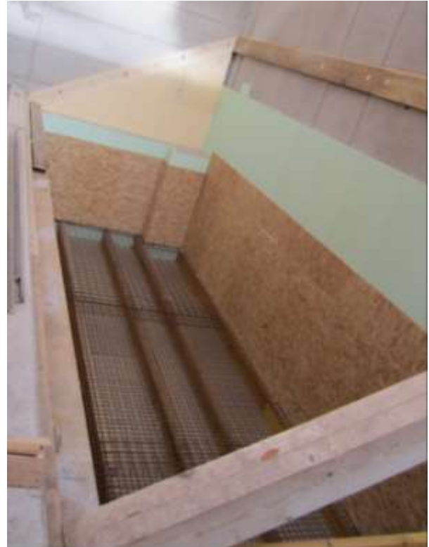
Abbildung 216: Steinspeicher – zum Zeitpunkt der Aufnahme noch im Bau befindlich, daher noch ohne Steine – der sich unter dem noch nicht fertiggestellten Schrägrost befindet. Die Luft wird durch das Gitter von unten in den Speicher geblasen (grün: Dämmschicht). Quelle: AIT
