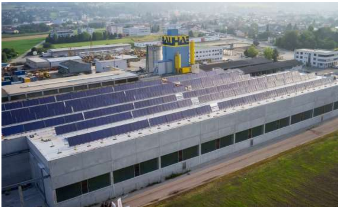
Abbildung 100: Ansicht der Fertigungshalle mit den aufgeständerten Kollektoren (Bildquelle: www.kuster.co.at )
