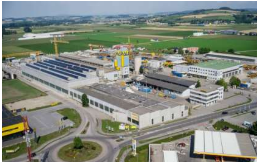
Abbildung 99: Ansicht des Firmengeländes der Fa. HABAU (Bildquelle: HABAU)
