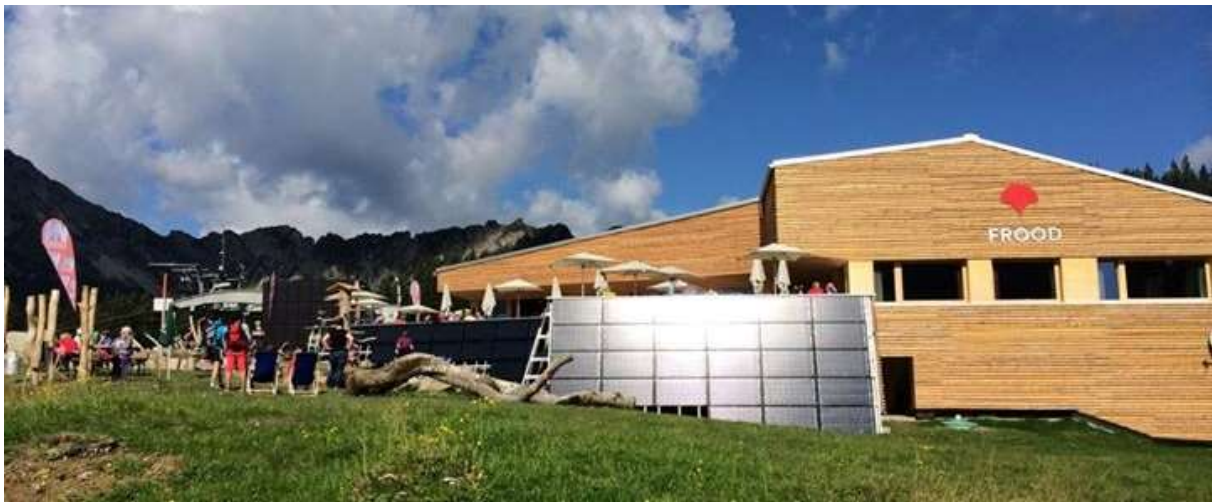
Abbildung 6: Ansicht des Bergrestaurants „Burtschasattel“ inkl. Ansicht des Hybridkollektorfeldes in der Fassade des Bergrestaurants im Vordergrund der Abbildung (Quelle: Frööd)
