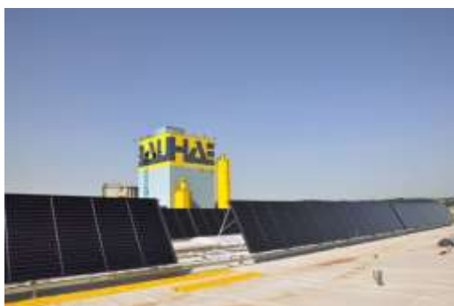
Abbildung 101: Aufständigung der Kollektorreihen am Dach der Fertigungshalle (Bildquelle: Linke Abbildung: www.gasokol.at , Rechte Abbildung: HABAU)
