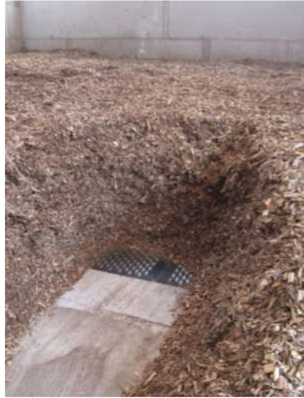
Abbildung 220: Mit Hackschnitzel beladener Flachrost. Rost zur Demonstration teilweise freigelegt. Quelle: AIT
