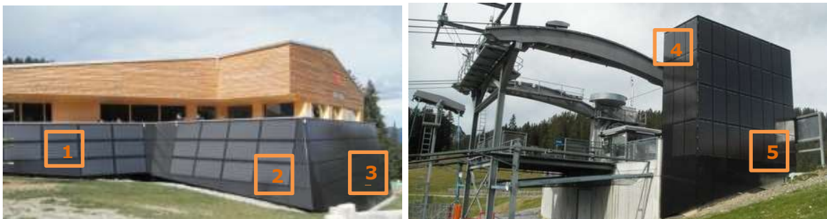
Abbildung 7: Darstellung der einzelnen Kollektorfelder der Anlage „Brandnertal Gastronomie“. Linkes Bild zeigt die beiden thermischen Flachkollektorfelder (1 und 2) sowie ein Hybridkollektorfeld (3). Rechte Abbildung zeigt zwei Hybridkollektorfelder an der Fassade der Bergstation (4 und 5) (Bildquelle: www.solartor.cc).
