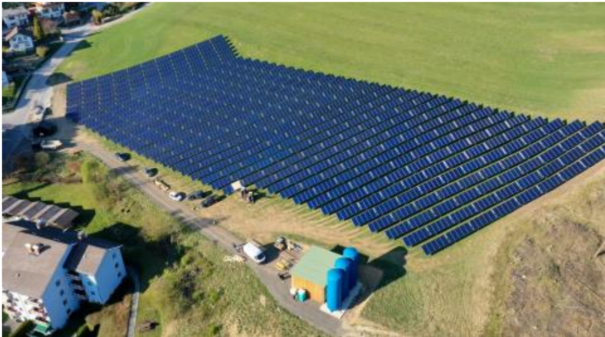
Abbildung 71: Luftaufnahme der Solaranlage mit den drei jeweils 60 m 3 Pufferspeichern im Vordergrund. (Quelle: SOLID Solar Energy Systems GmbH)
