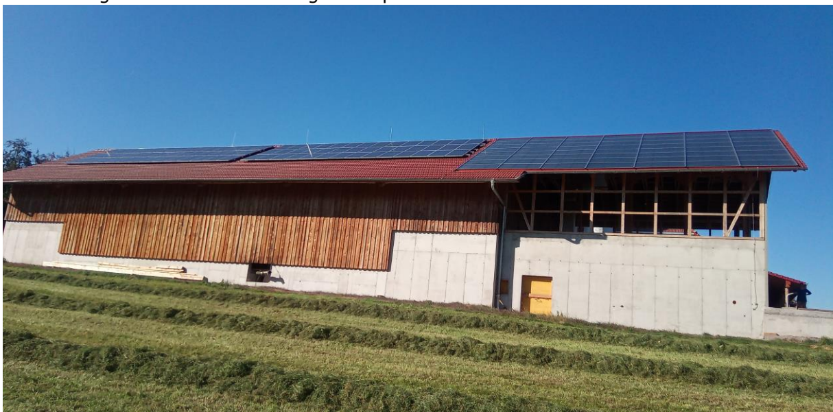
Abbildung 118: Luftkollektoranlage (rechts) und 30 kWp Photovoltaik-Anlage (links) auf dem Dach der Trocknungshalle (Quelle: AEE INTEC)
