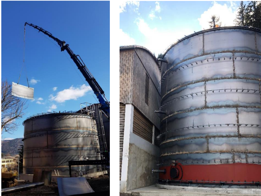
Abbildung 56: Errichtung des drucklosen 1.000 m 3 Pufferspeichers (Quelle: SolarEngineering Guggenberger)
