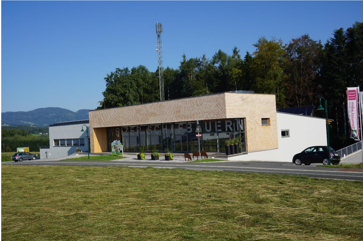
Abbildung 133: Südostansicht des Gebäudes „Weizer Schafbauern“ (Quelle: AEE INTEC)
