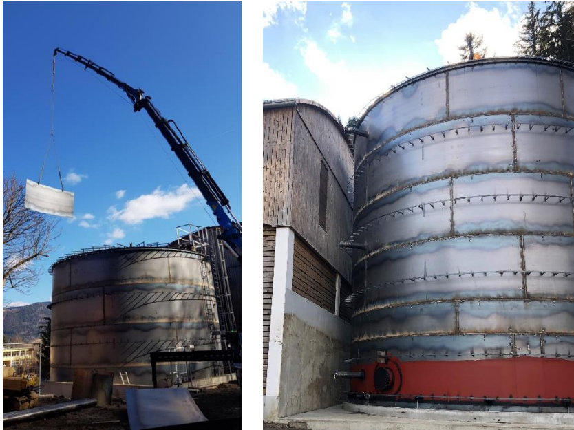
Abbildung 1: Errichtung des drucklosen 1.000 m 3 Pufferspeichers (Quelle: SolarEngineering Guggenberger)
