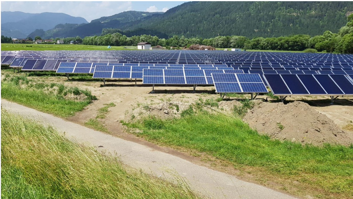
Abbildung 2: Nach der Montage des Solarfeldes, 5.750 m 2 Solarthermie + 25 kWp Photovoltaik zur Erzeugung des Pumpenstroms (Quelle: SolarEngineering Guggenberger)
