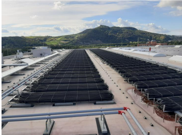
Abbildung 1: Bau des Eisspeichers (links, Quelle: IKEA), ungedeckte Absorbermatten sowie Photovoltaik-Anlage am Dach der Anlage Logistikzentrum IKEA (rechts) (Quelle: AEE INTEC)
