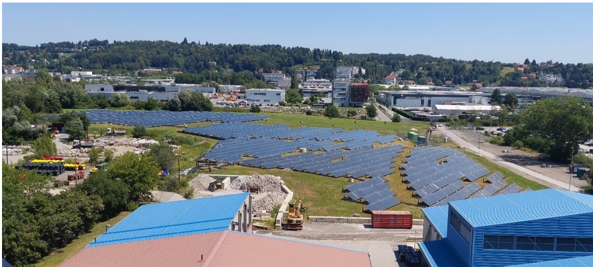
Abbildung 1: Kollektorfelder der Bauabschnitte I, II und III. (v.r.vorne n.l.hinten) der HELIOS Anlage, Graz (Quelle: Energie Graz).
