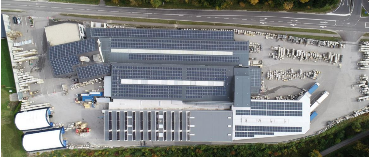
Abbildung 1: Draufsicht des Produktionsstandortes Oberwang der Firma BG – Graspöntner, Solaranlage im Bild unten (Quelle: BG - Graspöntner)
