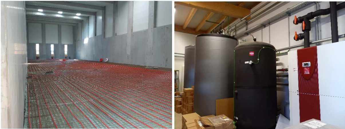
Abbildung 2: Verlegung der Bauteilaktivierung in der neu errichteten Halle (links), Pufferspeicher sowie Wärmepumpe (rechts) (Quelle: BG – Graspöntner)
