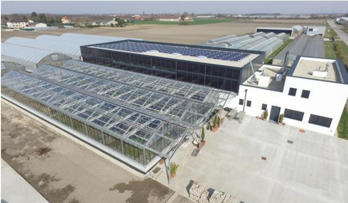
Abbildung 3: Südansicht der Gärtnererei Bach. Im Vordergrund die mit Bauteilaktivierung beheizten Glashäuser. Die Solaranlage ist in die Fassade integriert. Am Dach ist eine PV-Anlage installiert (Quelle: Bauherr)
