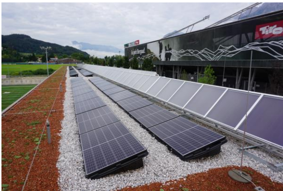
Abbildung 2: links: thermische Solaranlage am Dach, im Vordergrund eine 25 kWp PV-Anlage rechts: die drei parallel verschalteten Frischwassermodule (Quelle: AEE INTEC)
