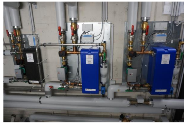
Abbildung 2: links: thermische Solaranlage am Dach, im Vordergrund eine 25 kWp PV-Anlage rechts: die drei parallel verschalteten Frischwassermodule (Quelle: AEE INTEC)
