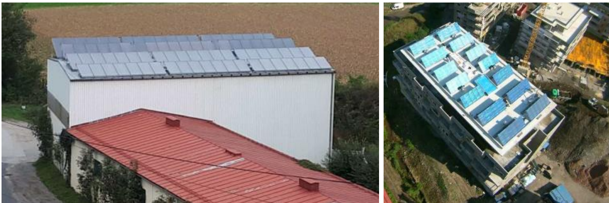
Abbildung 2: Kollektorfelder des Projekts „Energieinsel Landskron“. Links: Heizhaus. Rechts: Mehrparteienhaus (Bildquelle: asteenergy)
