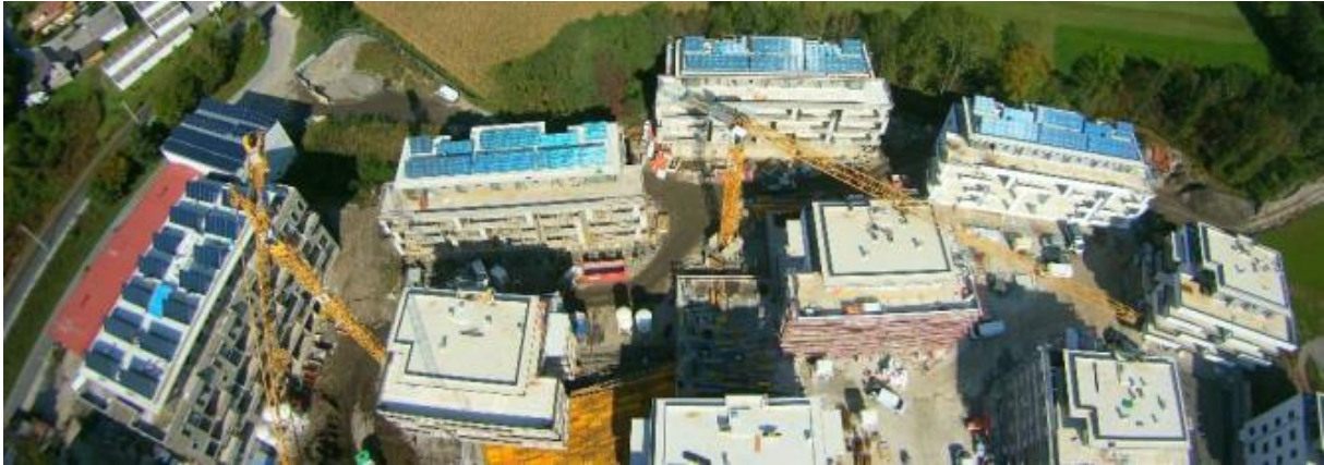
Abbildung 1: Panoramaansicht der neu errichteten bzw. im Bau befindlichen Mehrparteienhäuser des Projekts „Energieinsel Landskron“ (Bildquelle: asteenergy)
