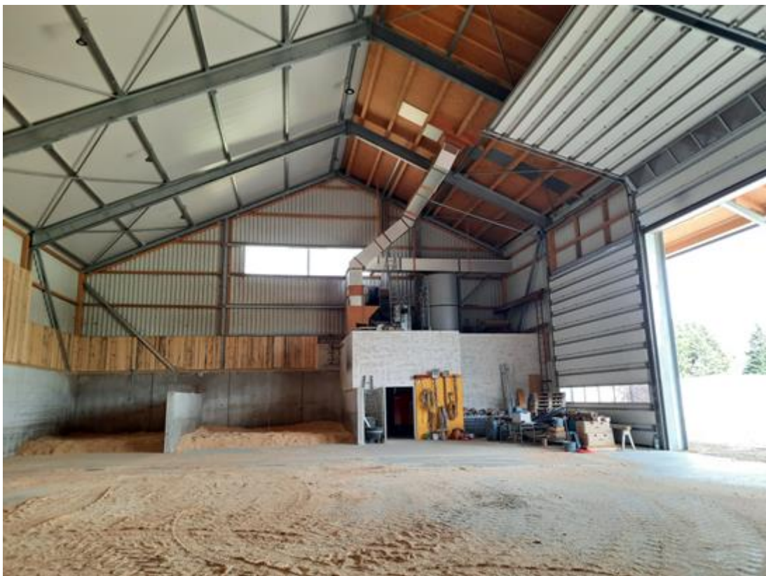
Abbildung 2: Innenraum der Trocknungshalle. Links sind die beiden Trocknungsroste erkennbar, rechts die beiden Solarleitungen vom Dach sowie die Mischkammer (Quelle: AEE INTEC)
