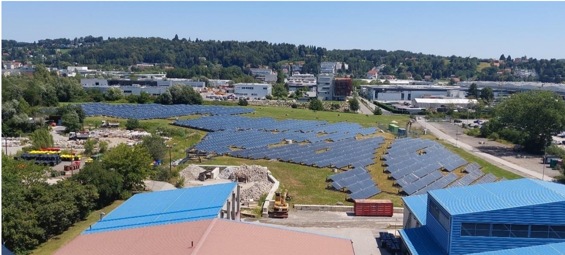
Abbildung 3: Kollektorfelder der Bauabschnitte I, II und III. (v.r.vorne n.l.hinten) der HELIOS Anlage, Graz (Quelle: Energie Graz).
