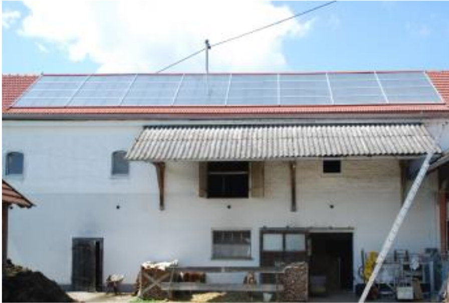
Abbildung 4 Östliches Luftkollektorfeld mit 65,4 m 2 (Quelle: FHOÖ F&E GmbH)
