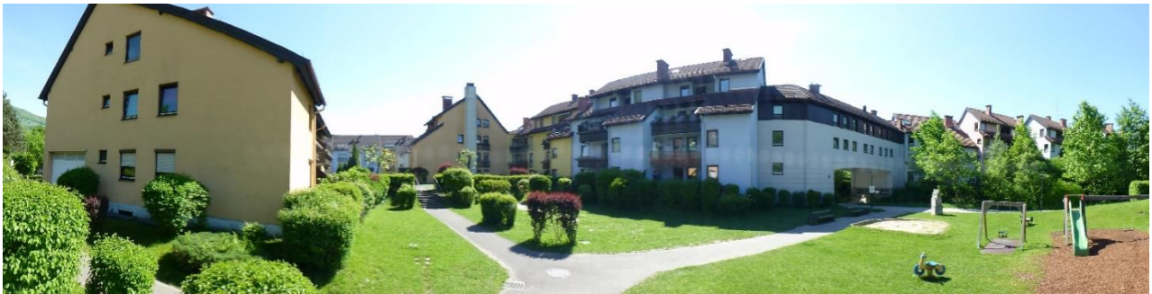
Abb. 12. Impressionen aus der Siedlung Friedrich-Inhauser-Straße Salzburg, Blick vom Norden: Spielplatz und Freiraumgestaltung
