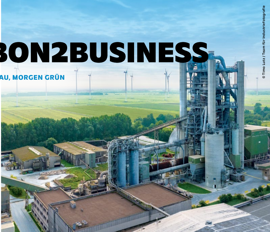
Zementwerk der Holcim Deutschland GmbH in Lägerdorf
