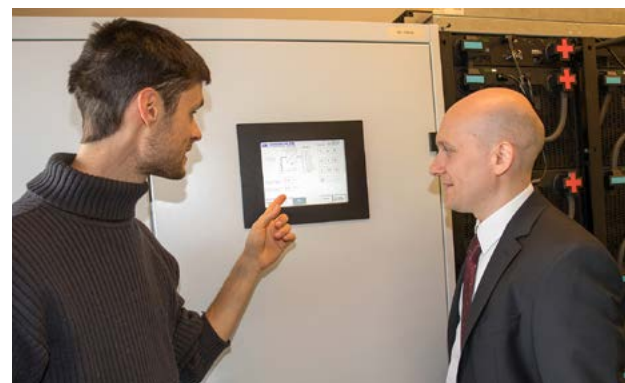
Speicher Heimschuh, alle Fotos oben: Energie Steiermark/Symbol
