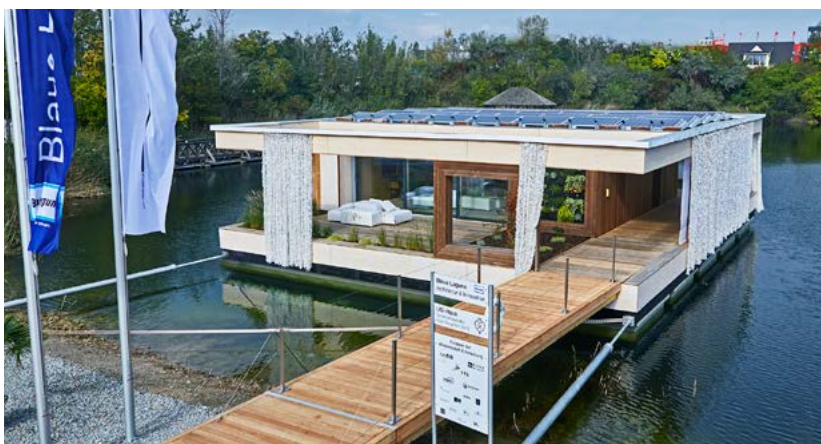
LISI – das Plus-Energie-Weltmeisterhaus – wurde 2013 beim internationalen Wettbewerb „Solar Decathlon“ in Kalifornien zum besten Solarhaus der Welt gekürt. Das Gebäude wurde in einem interdisziplinären Projekt unter Leitung der Technischen Universität (TU) Wien (DI Dr. Karin Stiefendorf, Institut für Architektur und Entwerfen) entwickelt und umgesetzt. www.solardecathlon.at Foto: Blaue Lagune/Thomas M. Laimgruber, blauelagune.at
