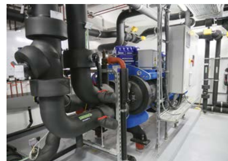
Eingangsbereich (oben), Kältemaschine (unten), Fotos: Projektfabrik Waldhör KG
