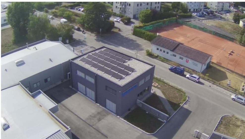
Neubau – 26 Module – 480 Wp
