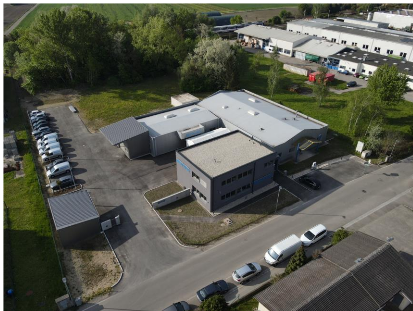
Vor der Errichtung
