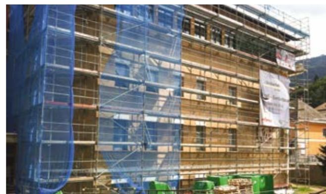
Volksschule Arnoldstein: Die Sanierung ist ein Musterprojekt dafür, welchen Beitrag öffentliche Gebäude zu Energiesparen und zum Klimaschutz leisten können.
