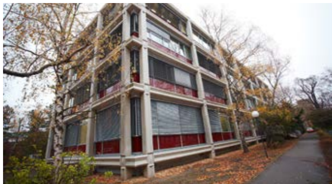
Das WIFO-Hauptgebäude wurde umfassend thermisch-energetisch saniert
