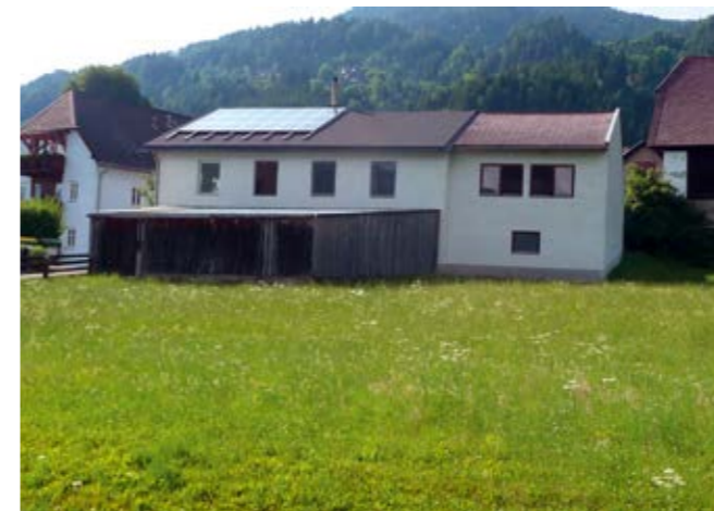
Betriebsgebäude vor der Sanierung
